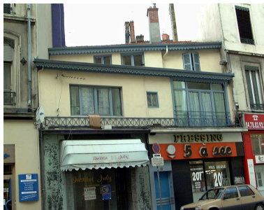
Vue générale depuis la rue Marietton Phot. Maryannick Chalabi IVR82_20006900384NUCA
