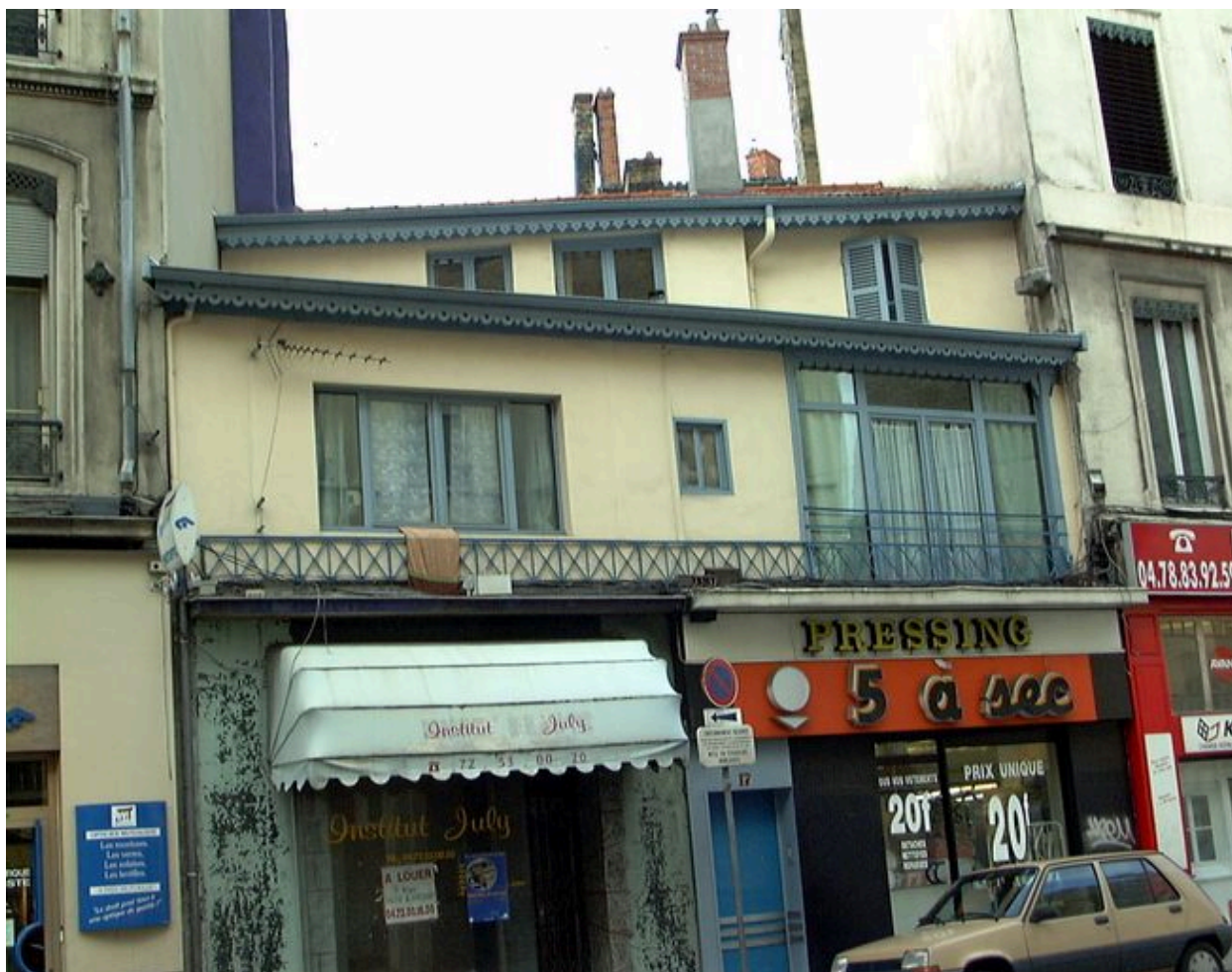
Vue générale depuis la rue Marietton
