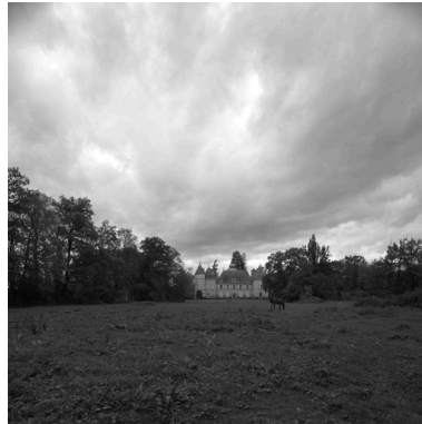
Vue générale de la partie nord, depuis le nord. Phot. Eric Dessert IVR82_20044201894NUC
