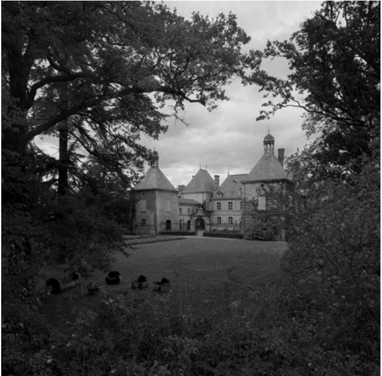
Vue d'ensemble de la partie sud, depuis le sud-est.
