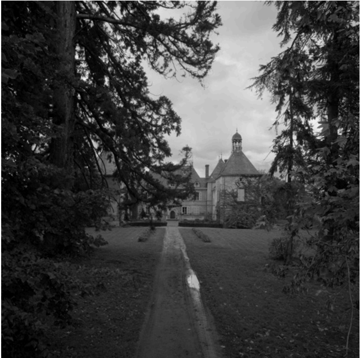
Vue d'ensemble de la partie sud, depuis le sud.
