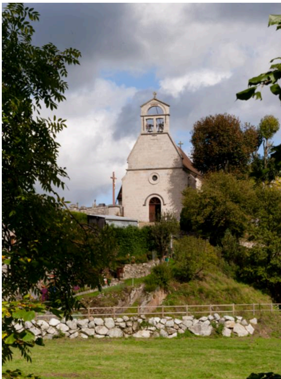
Vue générale de la façade occidentale.
