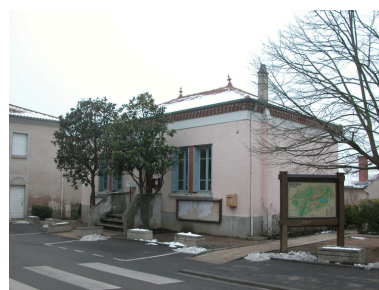
Vue d'ensemble de la mairie (1986 B2 438) depuis le nord-ouest. Phot. Caroline Guibaud IVR82_20114201409NUCA
