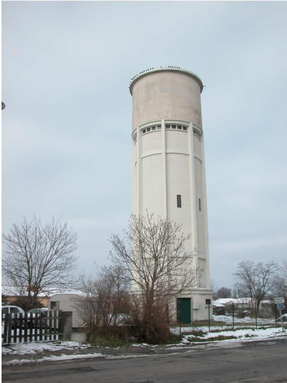
Vue du château d'eau (1986 B2 464). Inscription sur la porte : SYNDICAT DES EAUX / DE LA VIDREZONNE / 1963.
