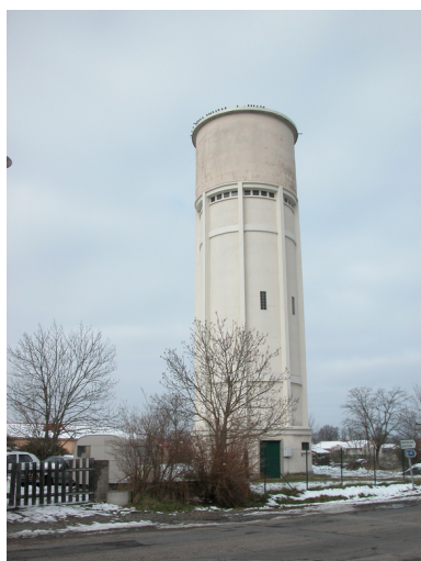
Vue du château d'eau (1986 B2 464). Inscription sur la porte : SYNDICAT DES EAUX / DE LA VIDREZONNE / 1963. Phot. Caroline Guibaud IVR82_20114201414NUCA
