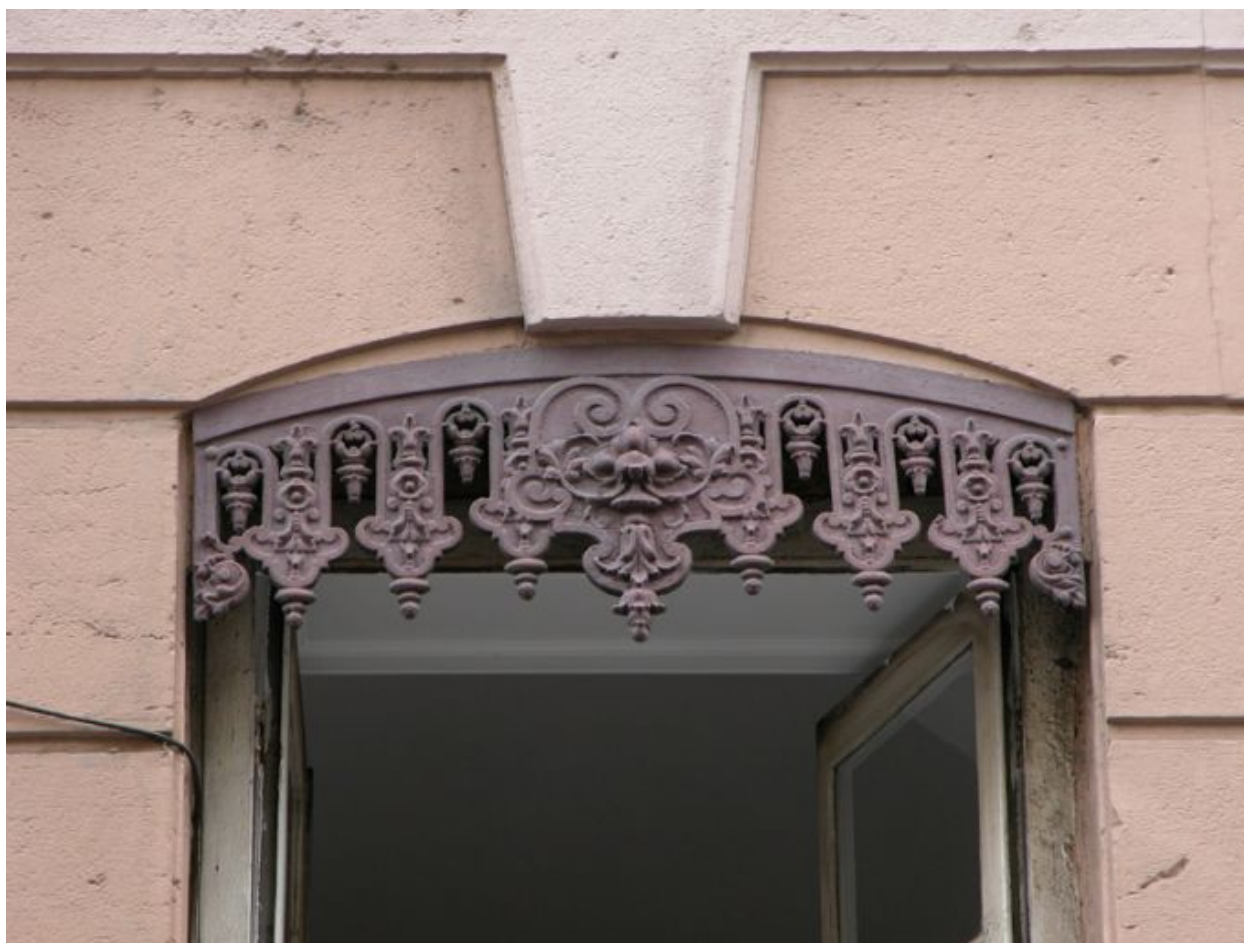
Façade, 2e niveau, 1ère fenêtre, détail du lambrequin
