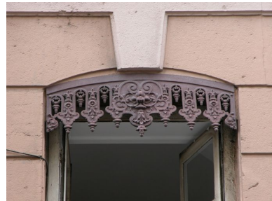
Façade, 2e niveau, 1ère fenêtre, détail du lambrequin Phot. Bernard Ducouret IVR82_20046905762NUCA
