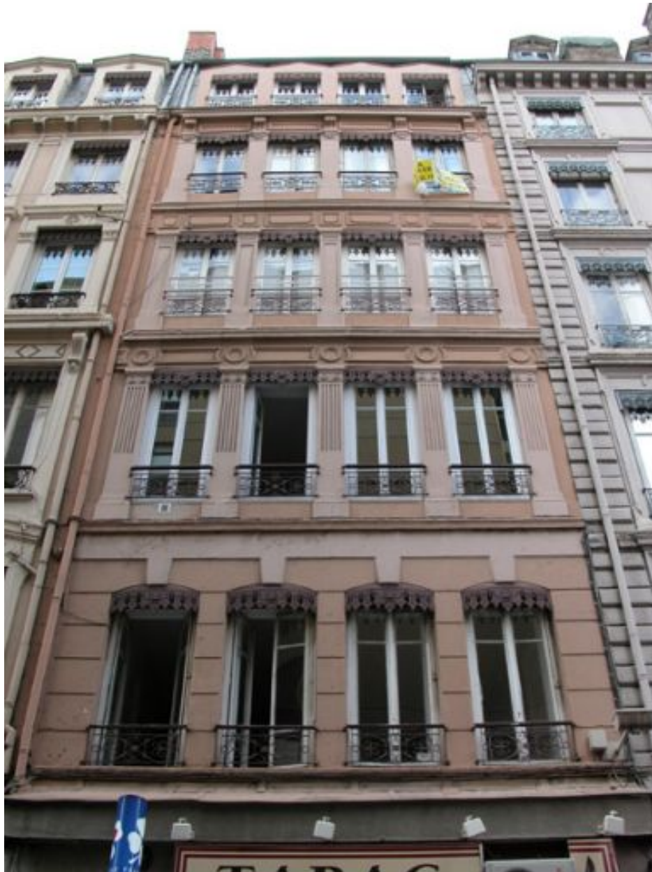
Façade, vue par-dessous
