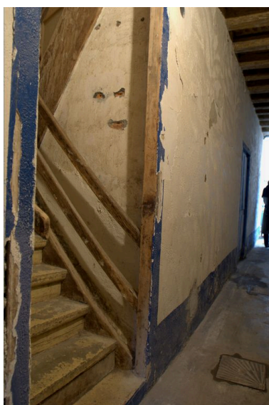
Le départ de l'escalier Phot. Maryannick Chalabi IVR82_20086900855NUCA
