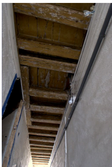
Le plafond à solives du couloir d'entrée Phot. Maryannick Chalabi
