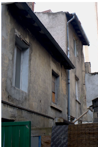
Elévation postérieure depuis le sud-ouest Phot. Maryannick Chalabi IVR82_20086900852NUCA
