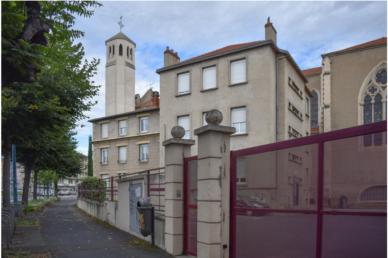
Elévation sud de l'ancienne école ménagère. Église Saint-Jeanne-d'Arc à l'arrière-plan.
