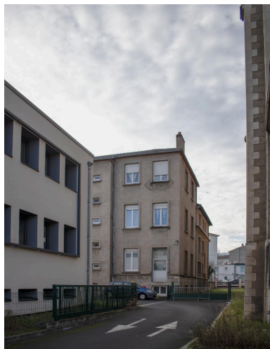
Extension de l'ancienne école ménagère (1947, Jean Bosser architecte) et allée la séparant de l'église sainte-Jeanne-d'Arc. Phot. Félicie Fougère IVR84_20256300268NUCA
