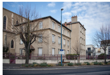
Façade sur le boulevard du bâtiment d'origine (1927, Charles Marc architecte). Elévation latérale de l'extension (1947, Jean Bosser architecte) Phot. Félicie Fougère IVR84_20256300266NUCA
