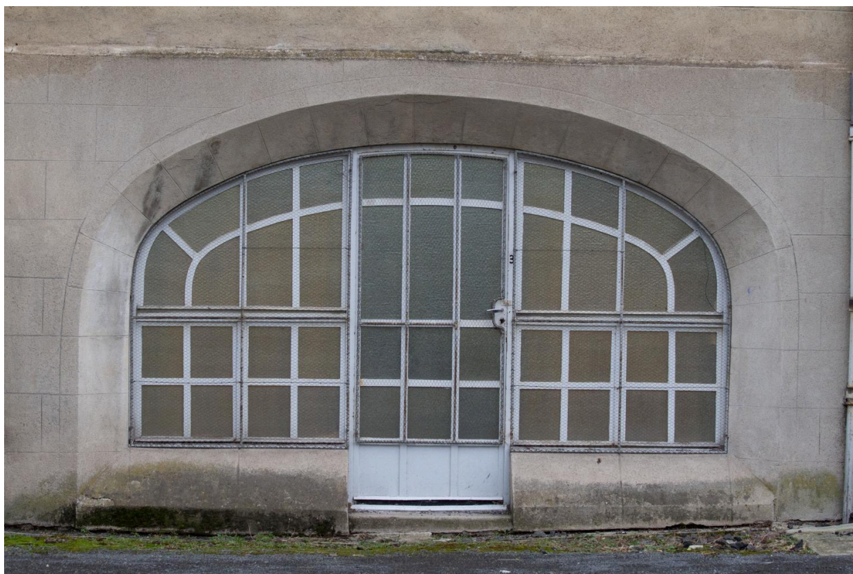
Ouverture du sous-sol
