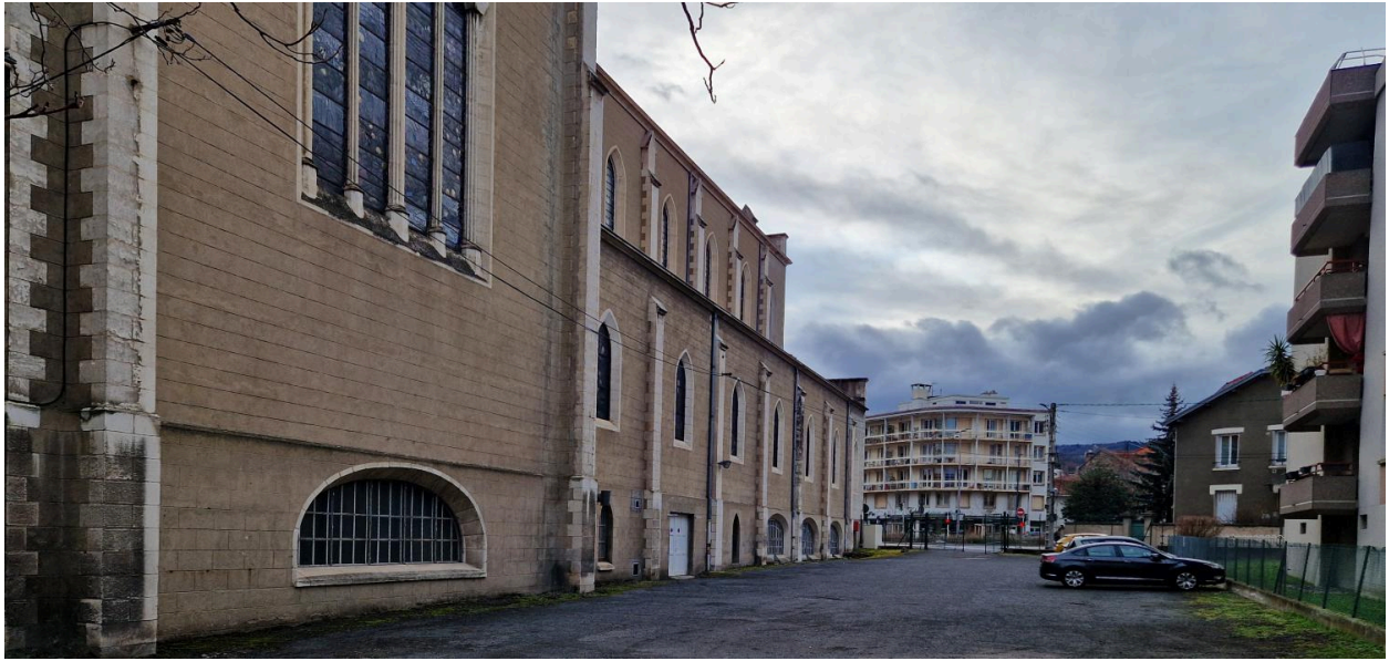
Flanc nord de l'église sainte Jean-d'Arc. A l'arrière-plan, façade de l'immeuble n°65 boulevard Jean-Jaurès (V. Vigneron architecte)
