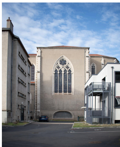
Bras sud du transept Phot. Félicie Fougère IVR84_20256300264NUCA
