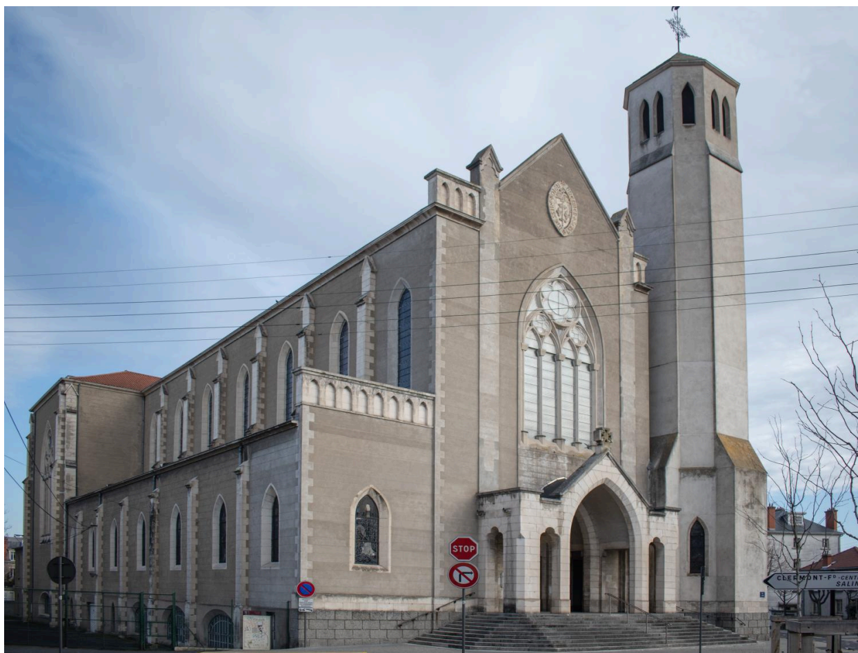
Façade et flanc nord-ouest
