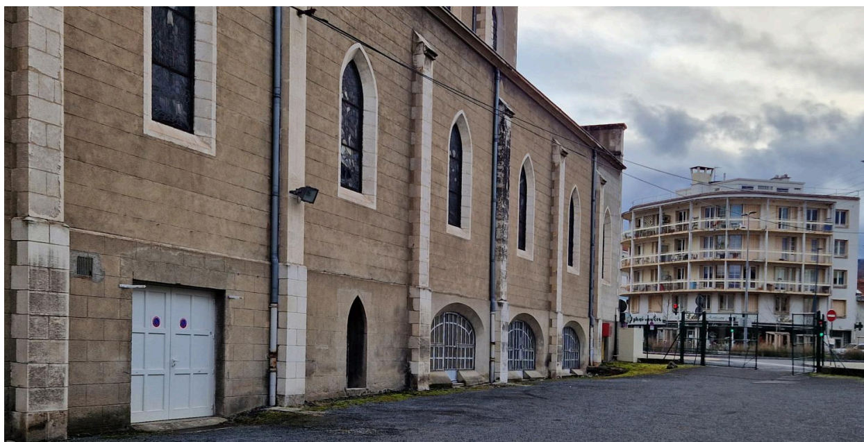
Flanc nord de l'église sainte Jean-d'Arc. A l'arrière-plan, façade de l'immeuble n°65 boulevard Jean-Jaurès (V. Vigneron architecte)
