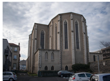
Chevet. A gauche, l'ancienne école ménagère. Phot. Félicie Fougère IVR84_20256300265NUCA
