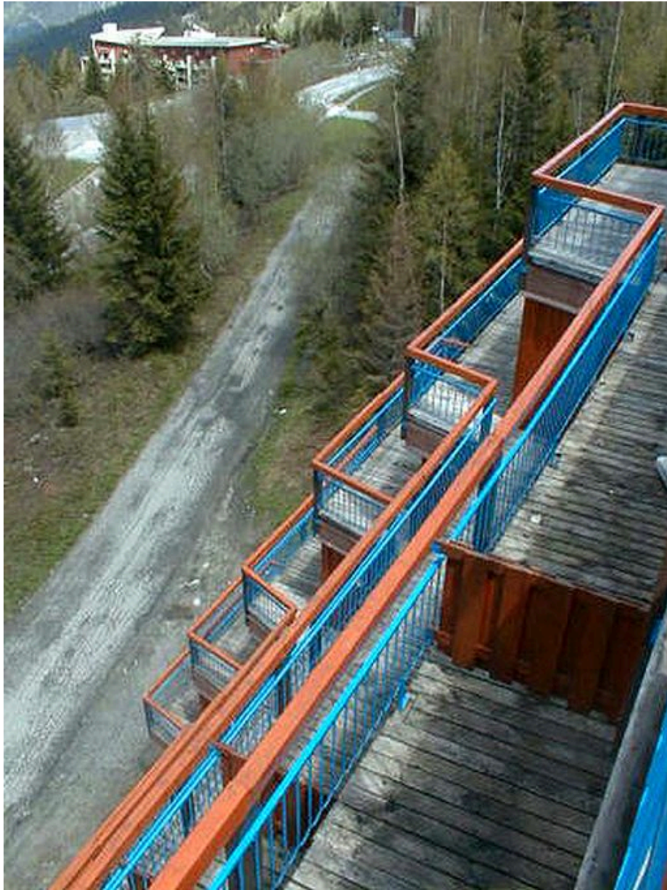
Terrasses des logements sur le pignon aval
