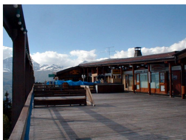
La terrasse supérieure Phot. C. Salomon IVR82_20057301266NUCA
