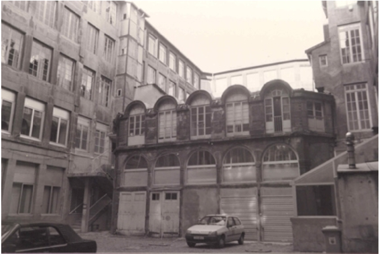
Façade sur cour
