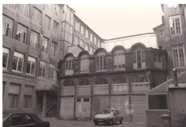
Façade sur cour Phot. Cendrine Sanquer IVR82_19974202014ZE
