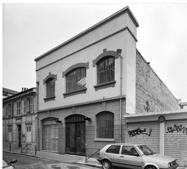
Atelier, vue sud-ouest Phot. Jean-Marie Refflé IVR82_20026904427V
