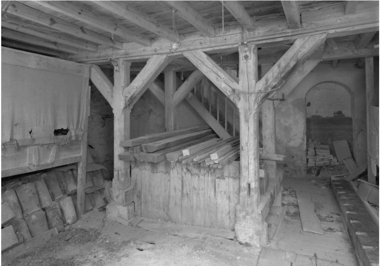
Intérieur du moulin, rez-de-chaussée, structure de soutien du plancher au droit des meules.
