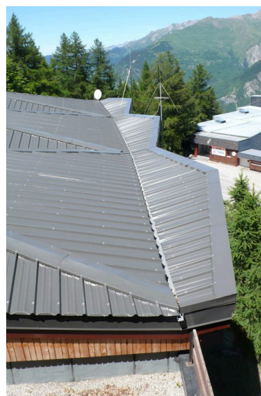
Détail de la toiture Phot. Jean-François Lyon-Caen IVR82_20127302333NUCA
