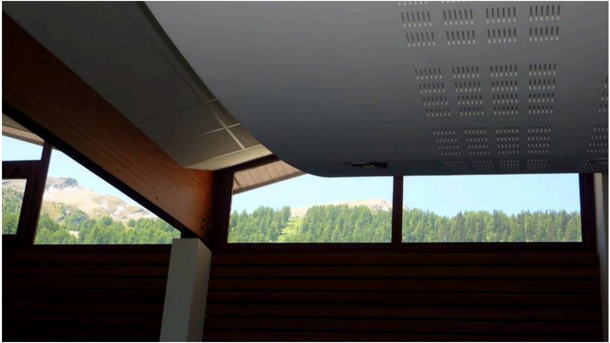
Détail du plafond du restaurant
