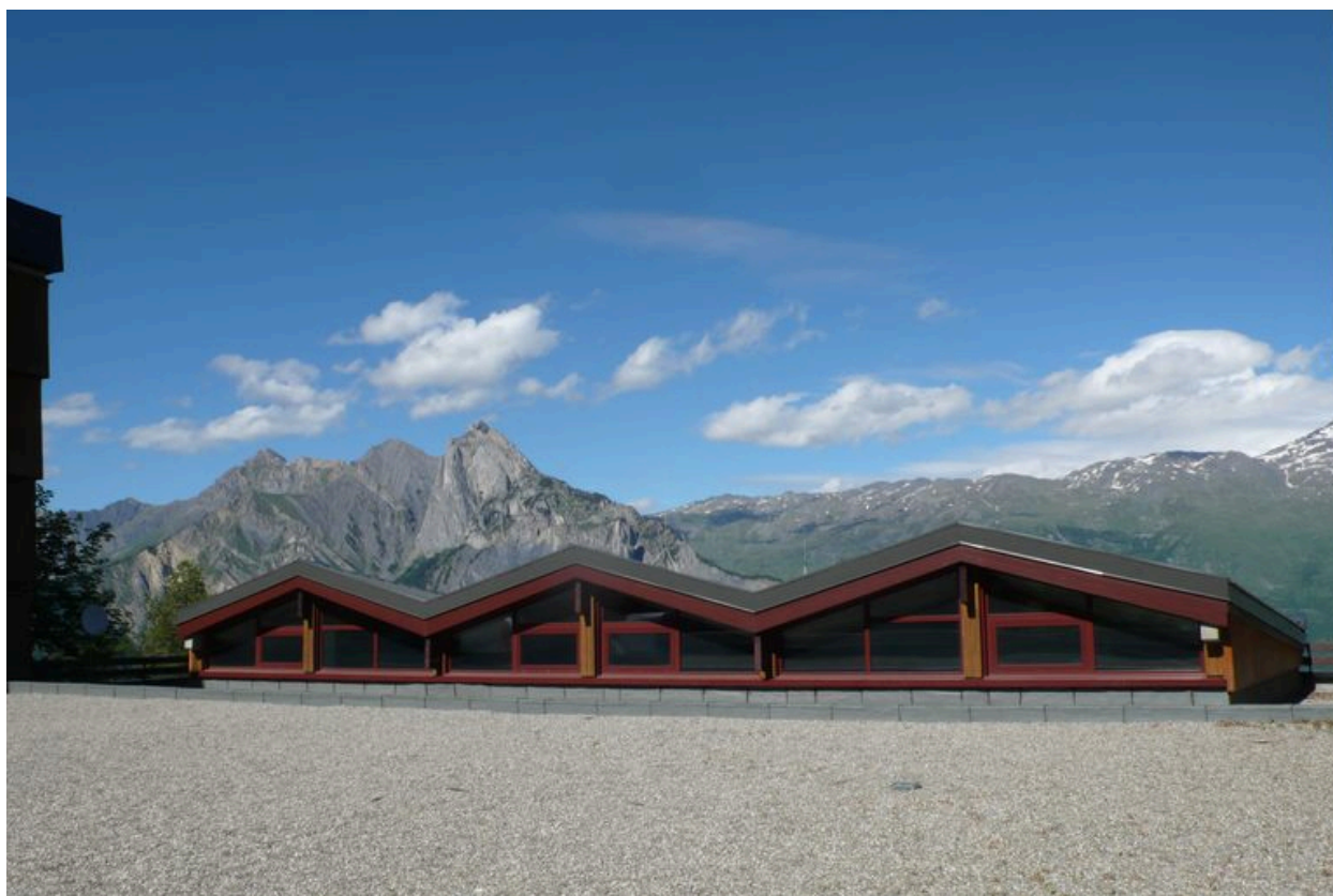
Le toit depuis le sud-ouest
