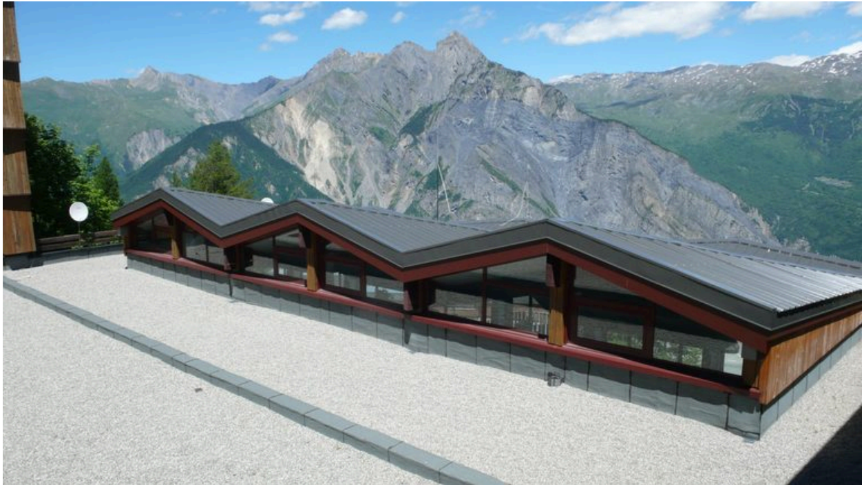
Toit du bâtiment B
