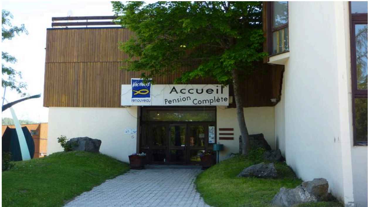
L'entrée du centre de vacances
