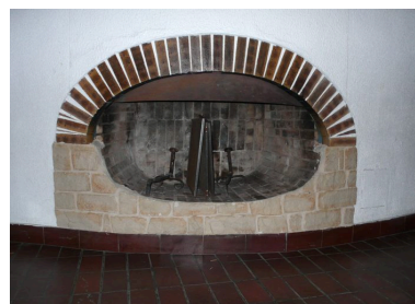
La cheminée Phot. Jean-François Lyon-Caen IVR82_20127302358NUCA
