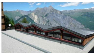
Toit du bâtiment B Phot. Jean-François Lyon-Caen IVR82_20127302331NUCA
