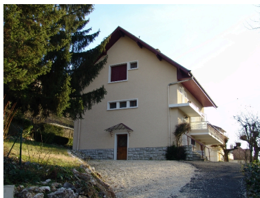
Vue de trois-quart gauche Phot. François Fouger IVR82_20087300099NUCA
