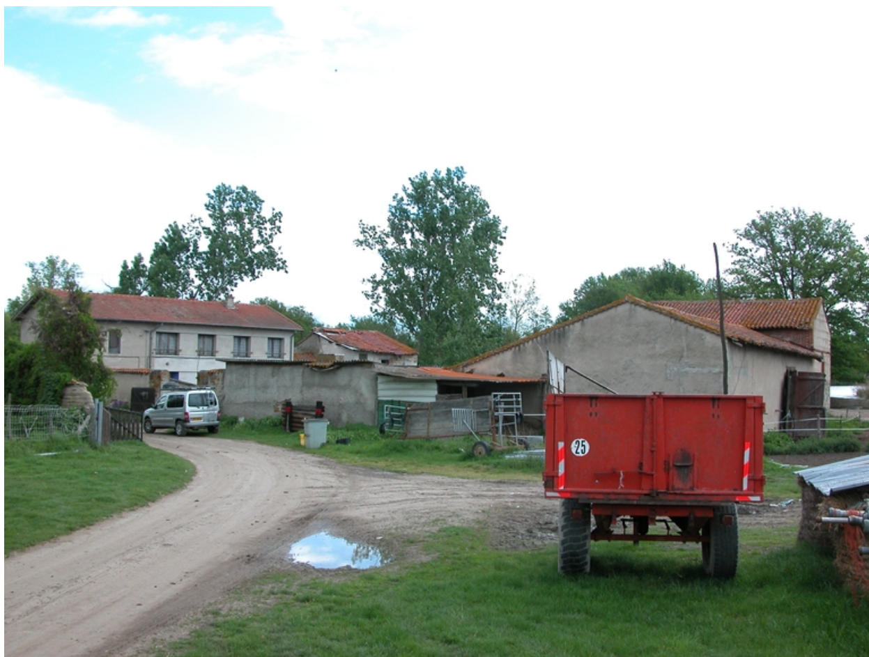
Vue générale depuis le sud-ouest.
