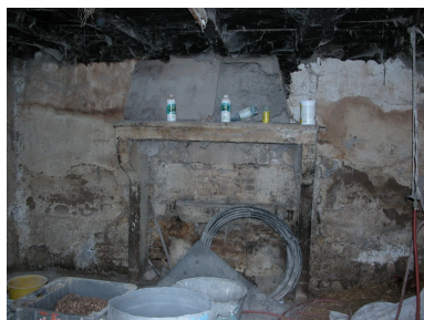
Vue intérieure du fournil. Phot. Thierry Monnet IVR82_20134201742NUCA
