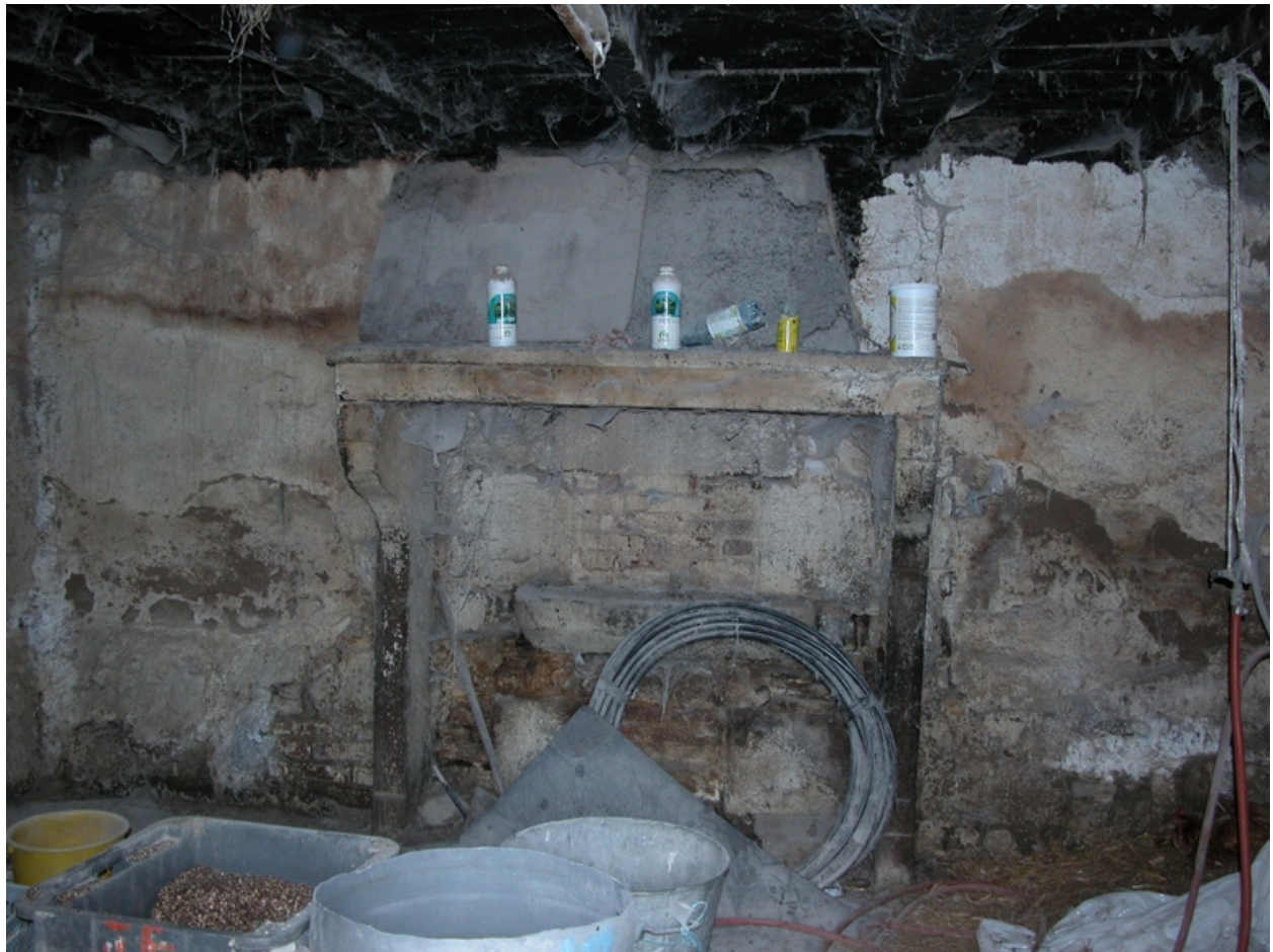
Vue intérieure du fournil.
