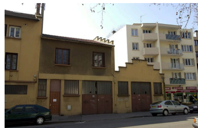
Atelier et bureau de la partie droite Phot. Véronique Belle IVR82_20036902003NUCA
