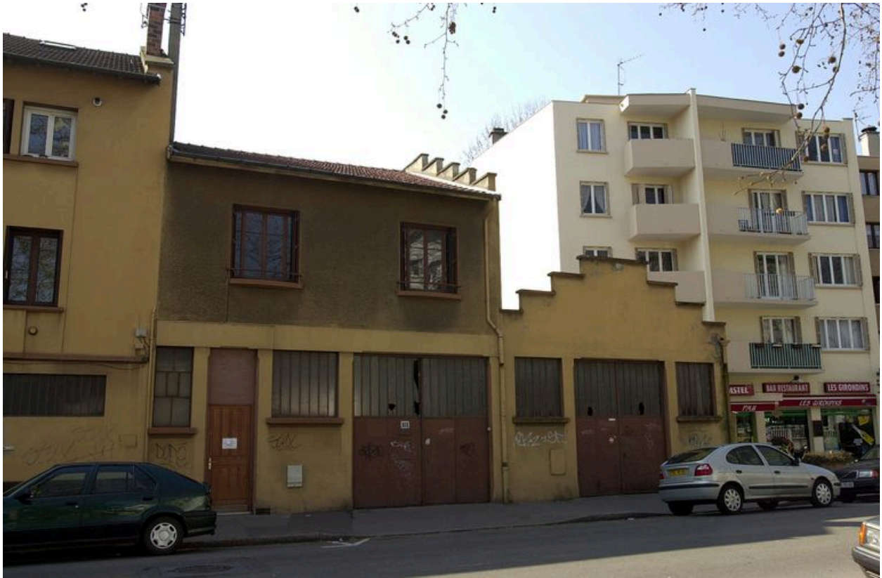
Atelier et bureau de la partie droite
