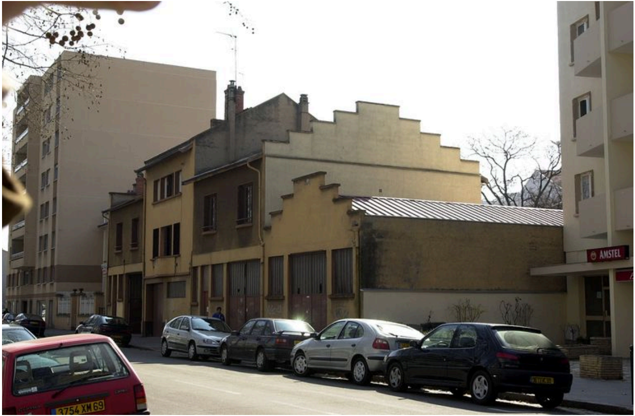
Vue générale, côté droit
