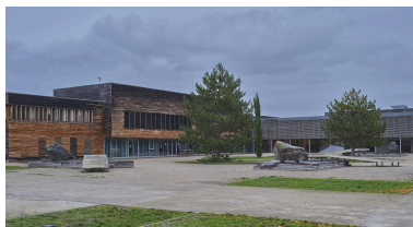
Vue d'ensemble des trois éléments dans la cour principale Phot. Franck Trabouillet IVR84_20256302312NUCA
