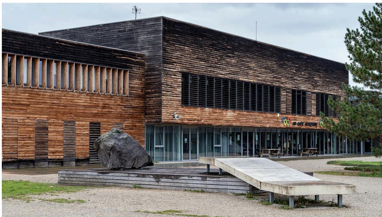
Vue d'un des éléments de la cour principale
