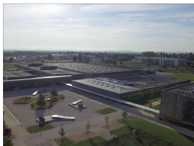
Vue aérienne ; on distingue une partie de l'installation dans la cour principale (A Lycée P.-J. Bonté) Repro. Catherine Guégan, Autr. auteur inconnu IVR84_20256302346NUCA
