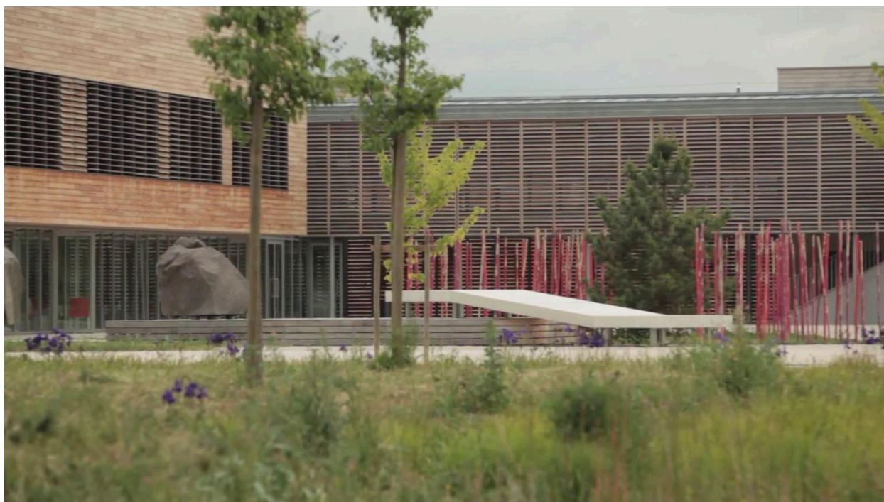
Vue de l'installation dans la cour principale v. 2015 (A Lycée P.-J. Bonté)
