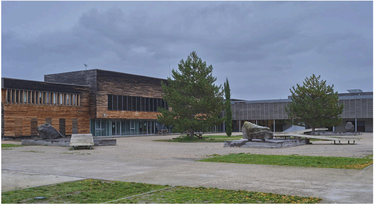
Vue d'ensemble des trois éléments dans la cour principale
