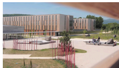
Vue de l'installation dans la cour principale et devant l'internat v. 2015 (A Lycée P.-J. Bonté) Repro. Catherine Guégan, Autr. auteur inconnu IVR84_20256302349NUCA
