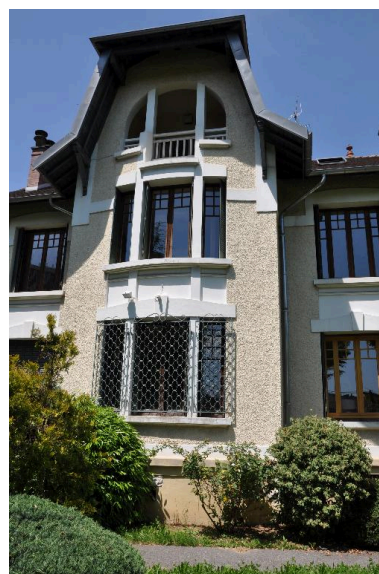
Détail de la travée centrale Phot. Denys Harreau IVR82_20137300453NUCA
