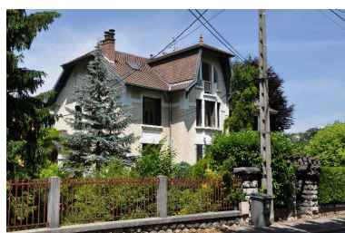
Vue d'ensemble Phot. Denys Harreau IVR82_20137300456NUCA
