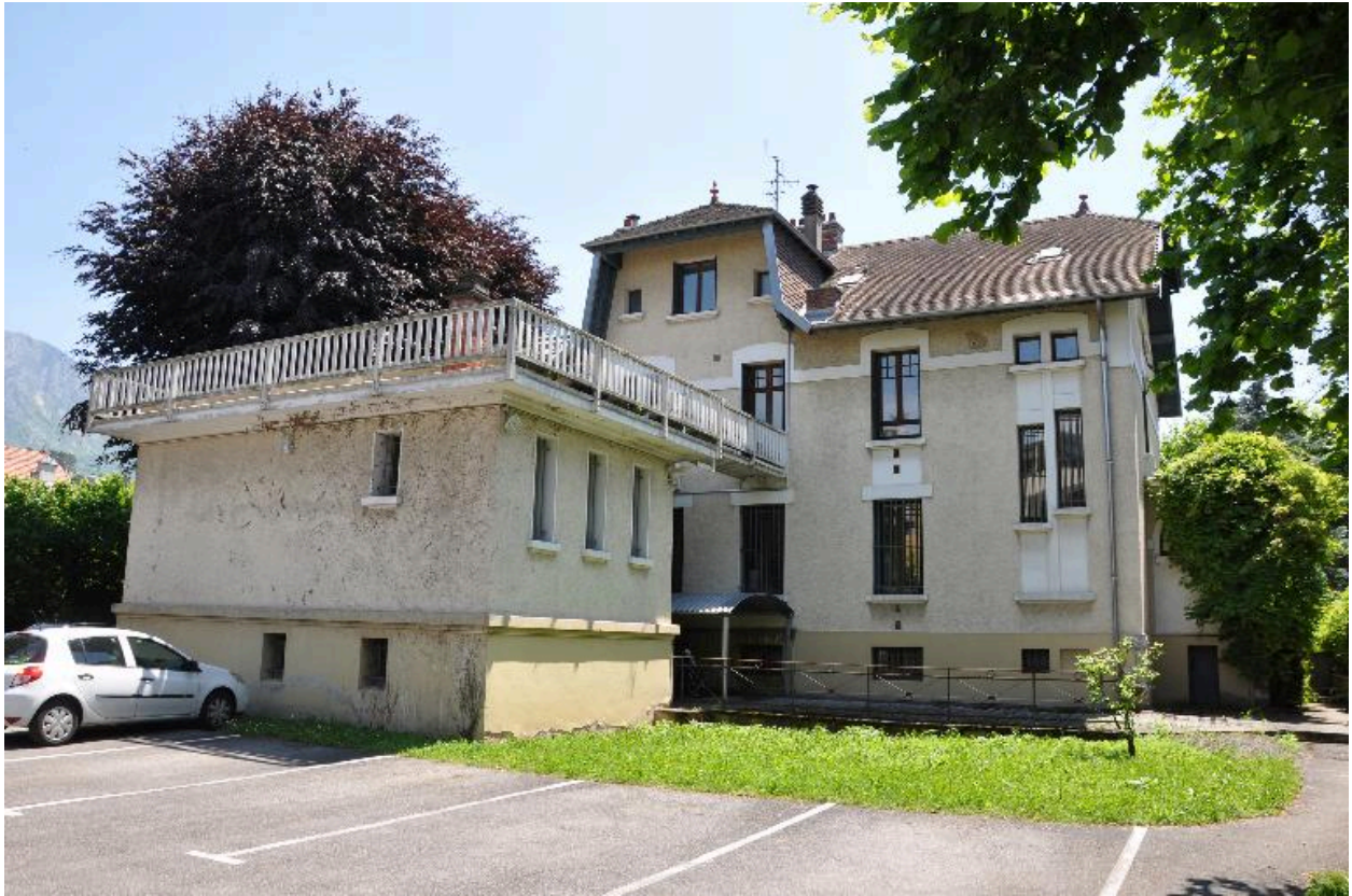
Vue depuis l'arrière
