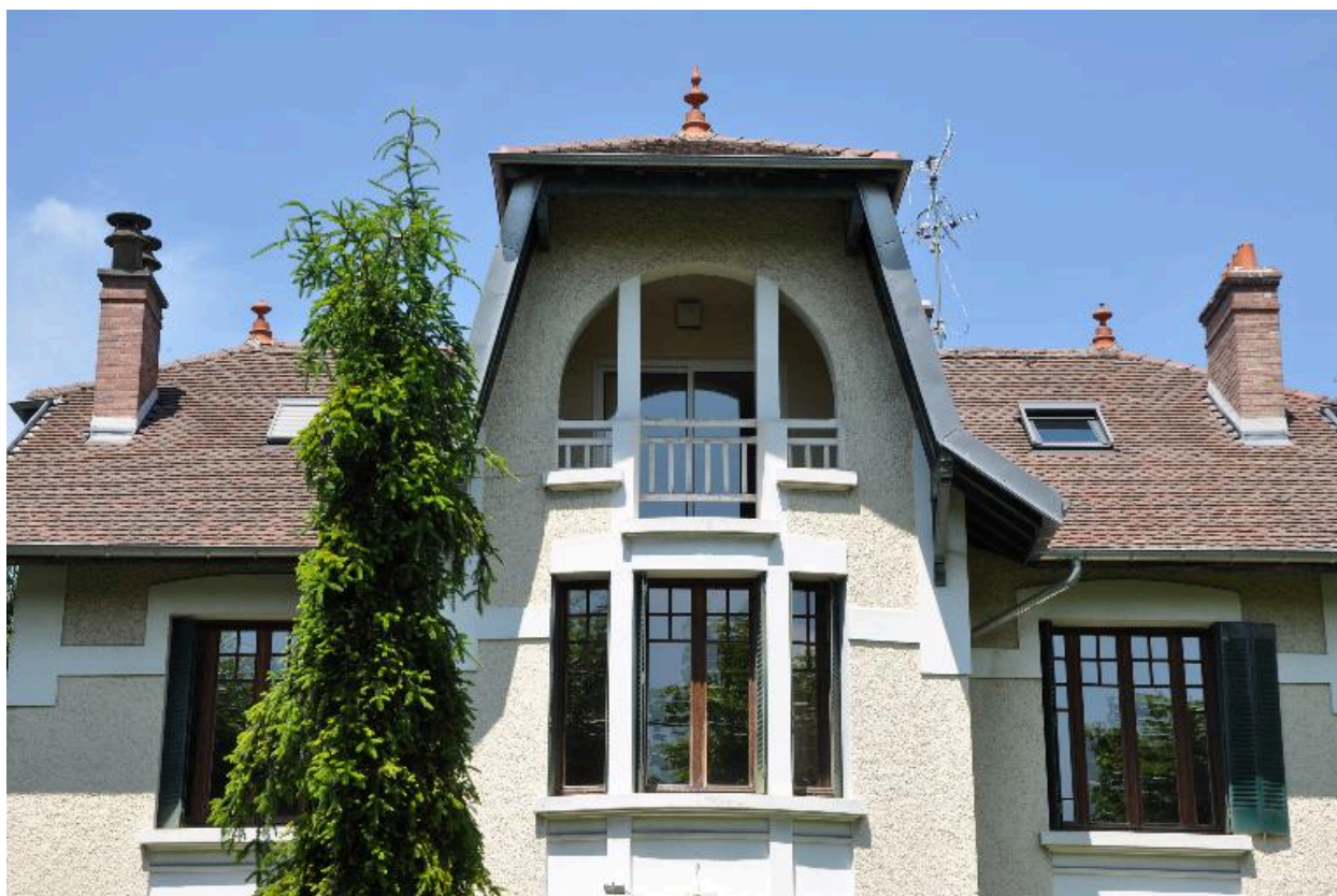
Détail de la lucarne-pignon et du balcon-loggia
