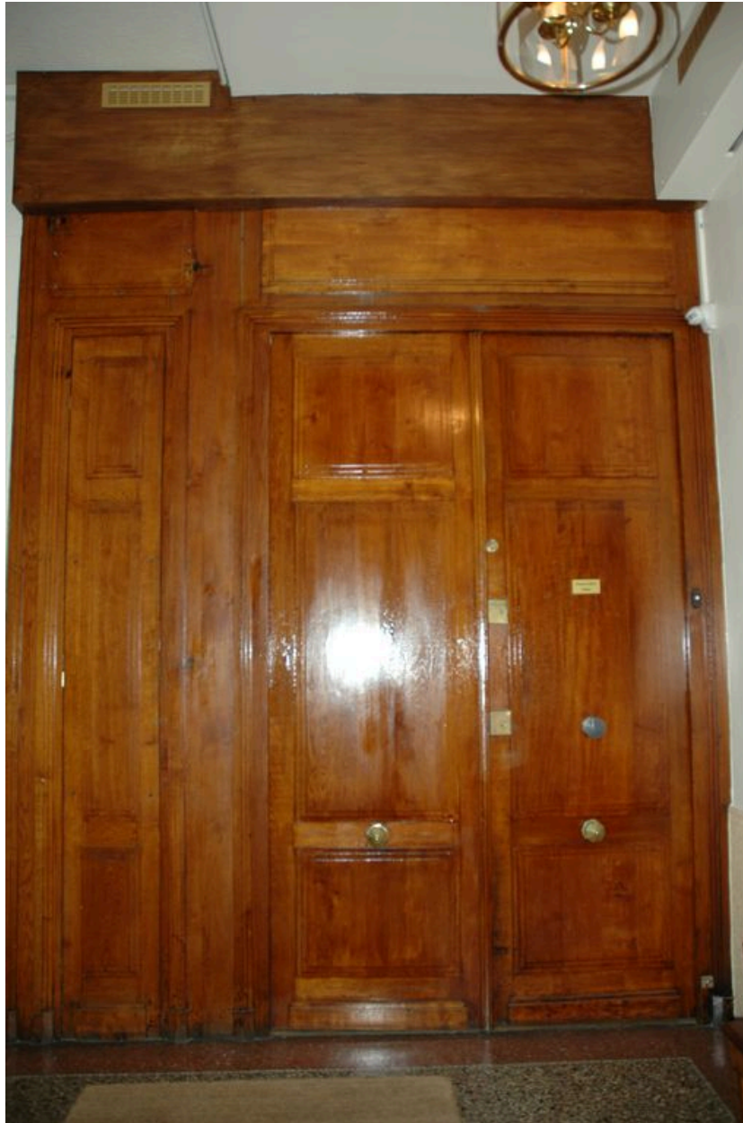
Porte d'appartement au rez-de-chaussée
