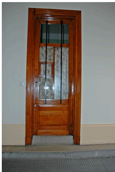
Porte de la loge de concierge Phot. Maryannick Chalabi IVR82_20066903094NUCA
