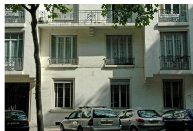
Détail du rez-de-chaussée et du balcon du 2e étage Phot. Maryannick Chalabi IVR82_20066903088NUCA
