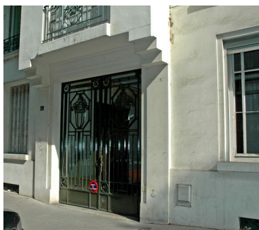
Vue de l'entrée Phot. Maryannick Chalabi IVR82_20066903087NUCA
