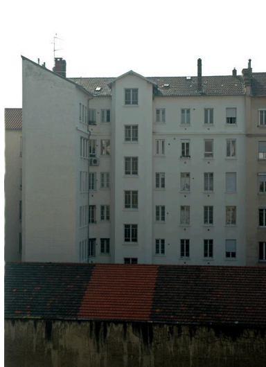
Elévation postérieure Phot. Maryannick Chalabi IVR82_20066903089NUCA
