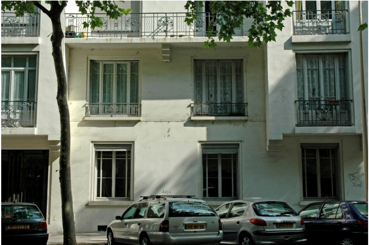
Détail du rez-de-chaussée et du balcon du 2e étage
