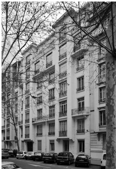
Vue d'ensemble depuis le sud-est Phot. Eric Dessert IVR82_20076901315NUC
