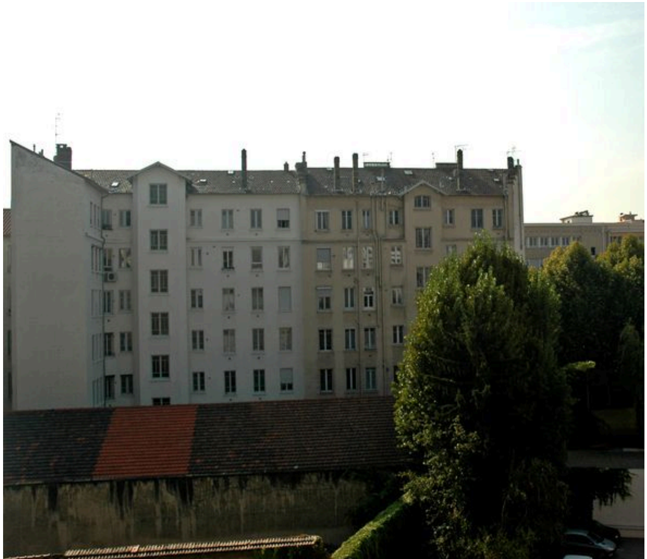
Elévations postérieures des 11 et 15 avenue Félix-Faure
