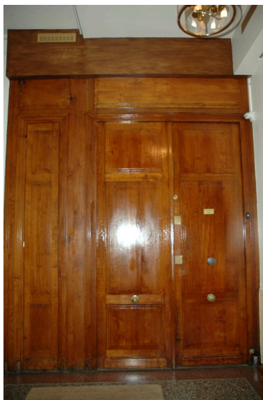
Porte d'appartement au rez-de-chaussée Phot. Maryannick Chalabi IVR82_20066903095NUCA
