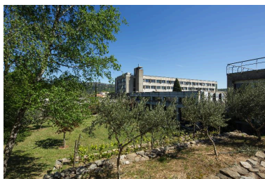
Vue du bâtiment sud et jardin du lycée Phot. Pascal Lemaître IVR82_20140700084NUCA
