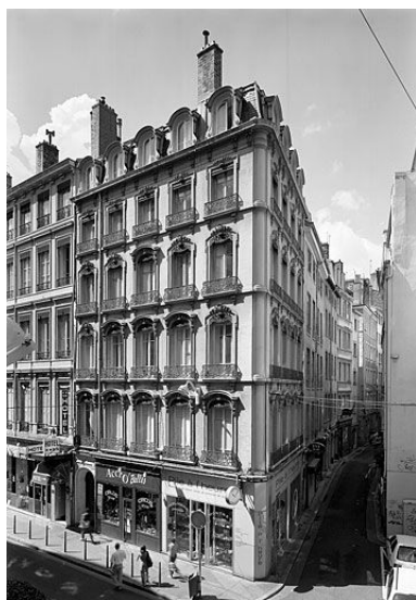
Vue générale des façades sur rue
