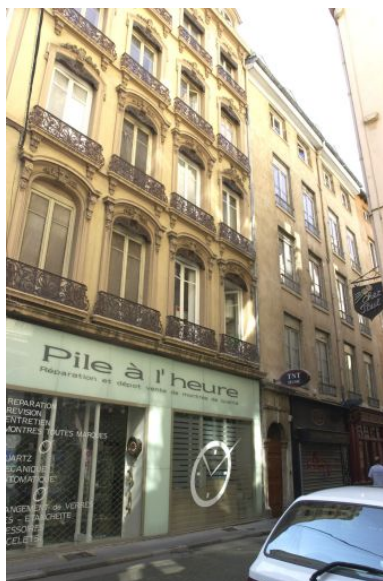
Façade sur la rue du Major-Martin, détail des trois 1ers niveaux Phot. Maryannick Chalabi IVR82_20036901059NUCA
