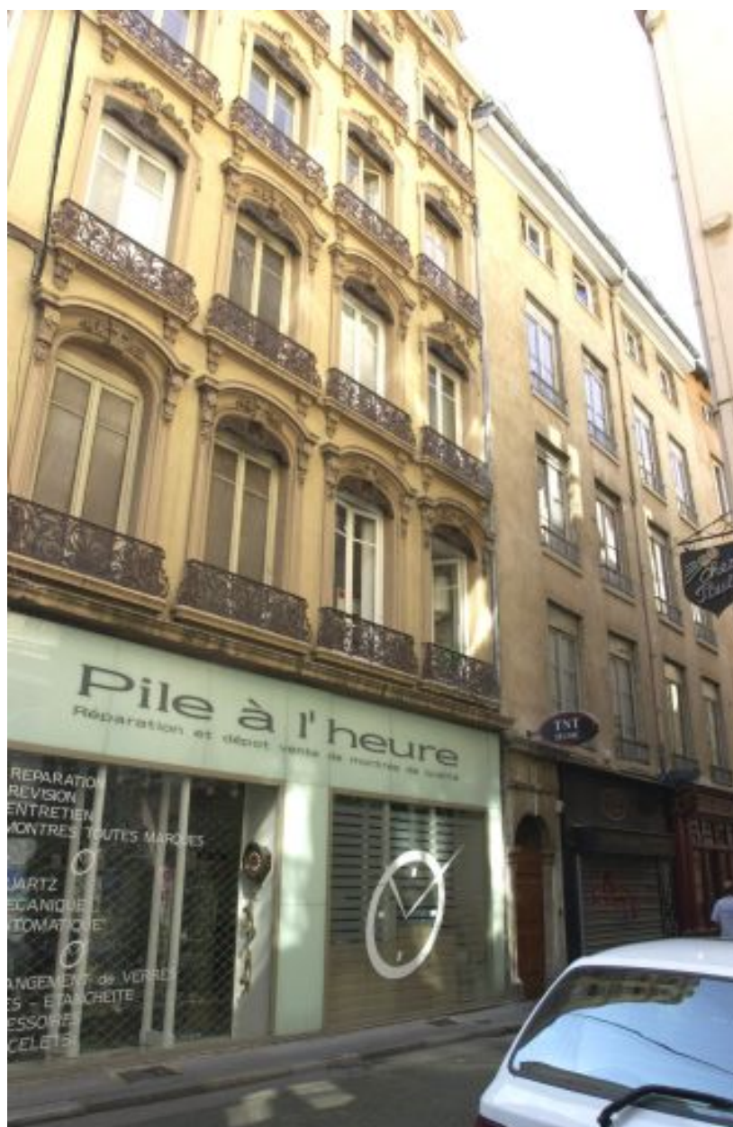
Façade sur la rue du Major-Martin, détail des trois 1ers niveaux
