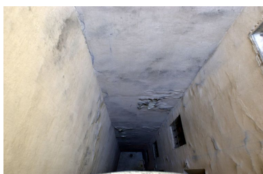
Vue de la cour depuis le haut de l'immeuble Phot. Bernard Ducouret IVR82_20036901259NUCA
