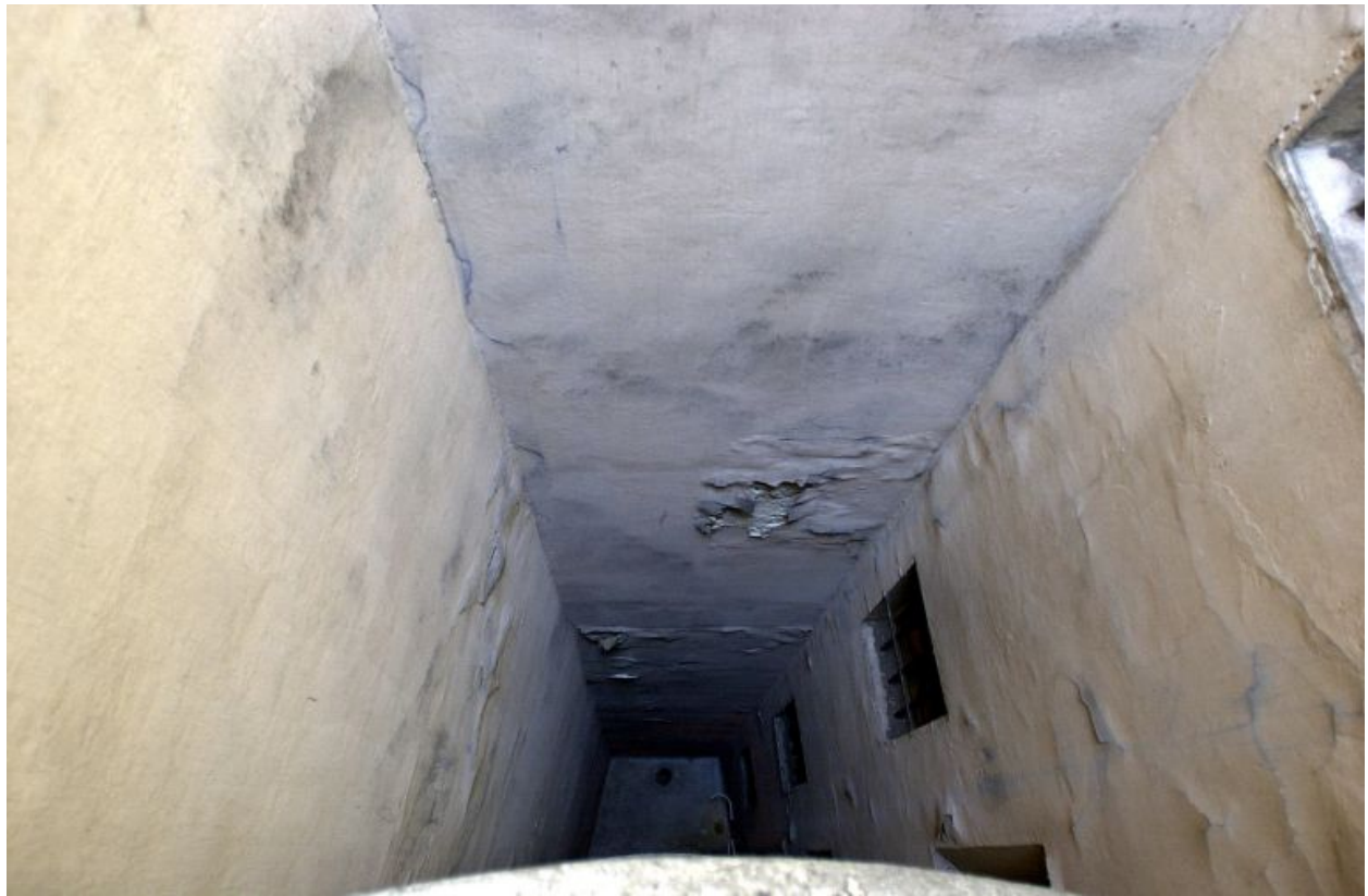
Vue de la cour depuis le haut de l'immeuble
