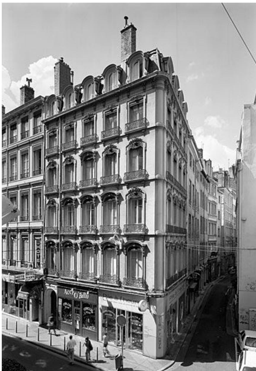
Vue générale des façades sur rue
