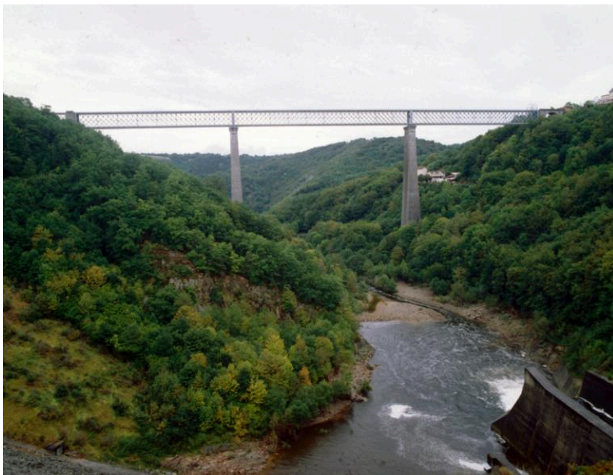
Vue générale du viaduc des Fades enjambant la Sioule.
