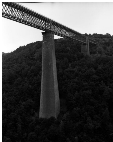
Une des piles du viaduc et une partie du tablier, depuis le bas.
