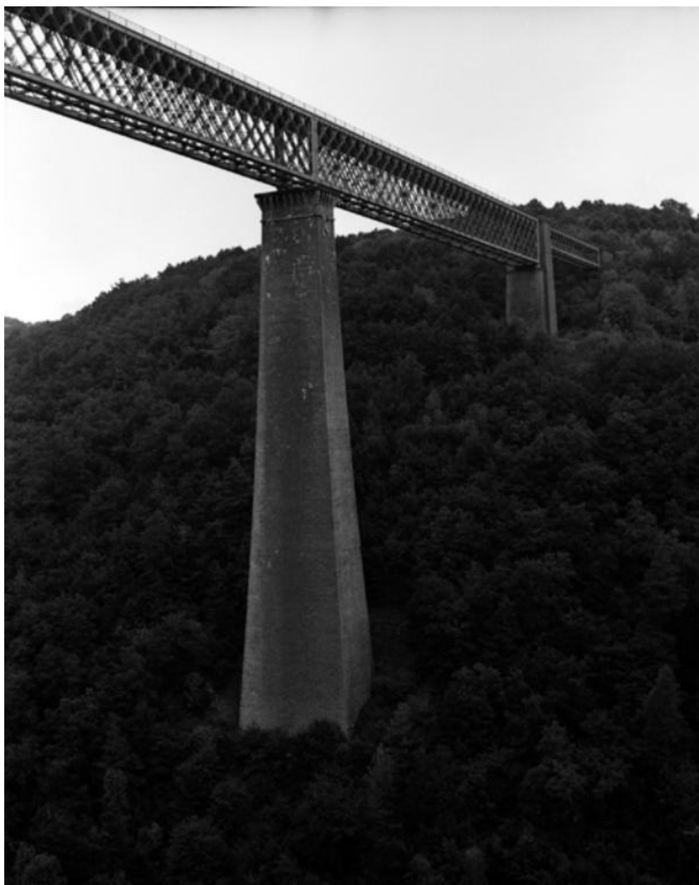
Une des piles du viaduc et une partie du tablier, depuis le bas.
