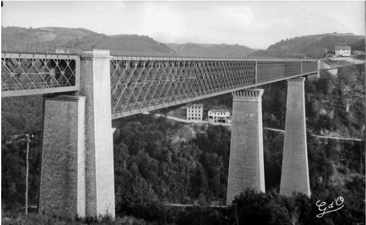
Le viaduc des Fades, la gare et les hôtels, vers 1925.
