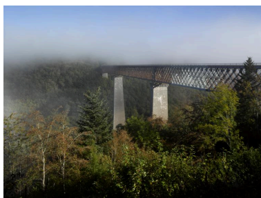
Le viaduc, à hauteur de tablier.
