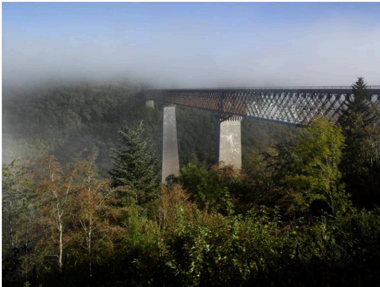
Le viaduc, à hauteur de tablier.
