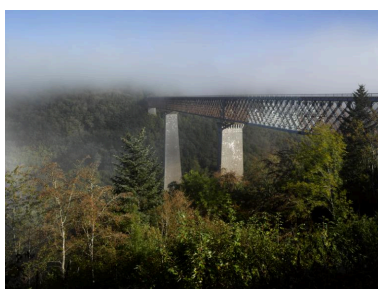
Le viaduc, à hauteur de tablier.
