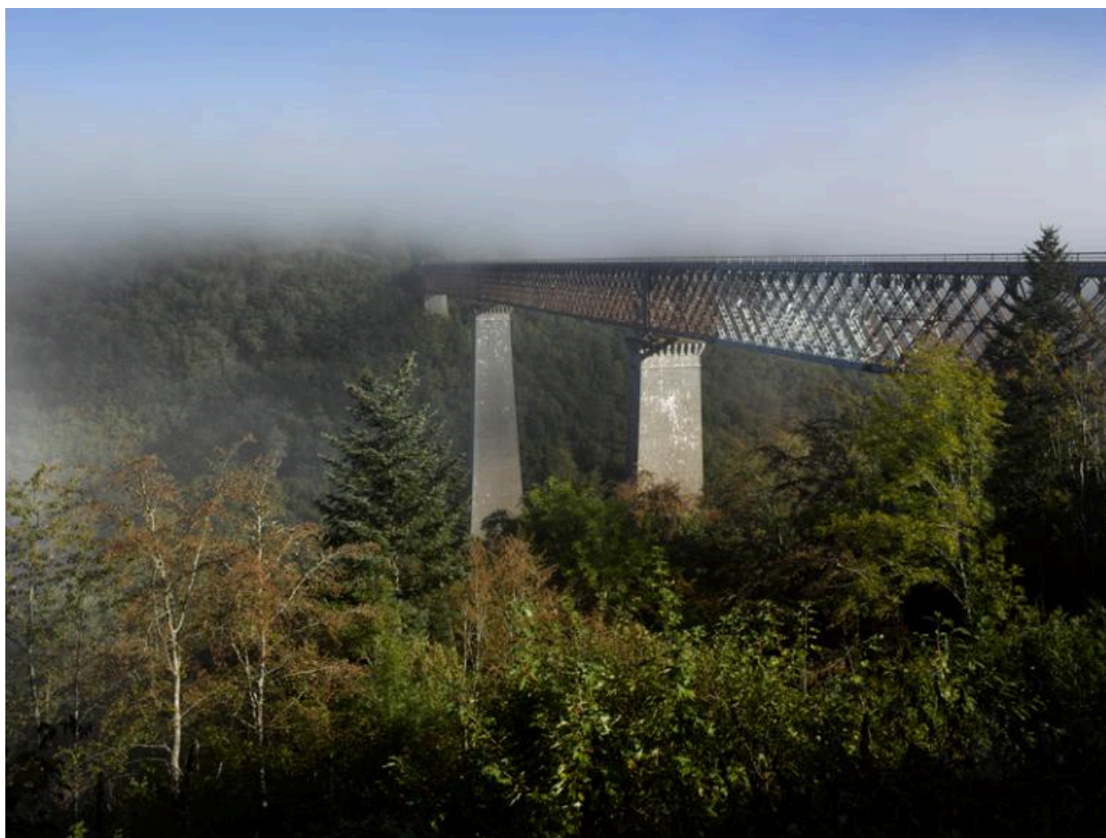
Le viaduc, à hauteur de tablier.
