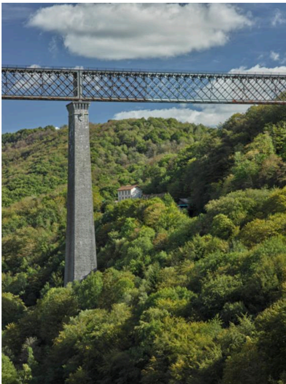
Détail du viaduc : pile en maçonnerie et tablier métallique.
