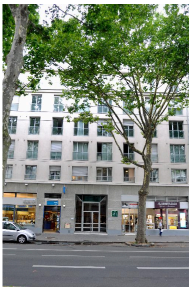
Immeuble 62 avenue Jean-Jaurès, élévation sur rue Phot. Magali Delavenne IVR84_20176901457NUCA
