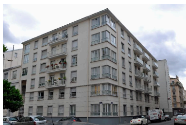
Immeuble 13 rue Saint-Jérôme, vue d'ensemble Phot. Magali Delavenne IVR84_20176901456NUCA
