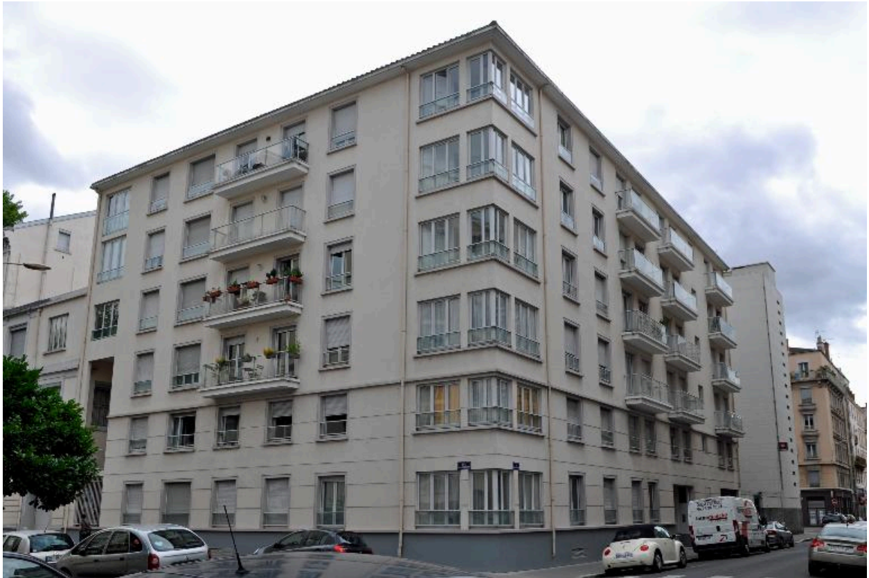
Immeuble 13 rue Saint-Jérôme, vue d'ensemble
