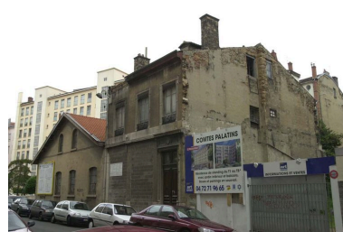
Vue générale des édifices démolis en 2001, depuis la rue Saint-Jérôme Phot. François Blanchetière IVR82_20016901581NUCA
