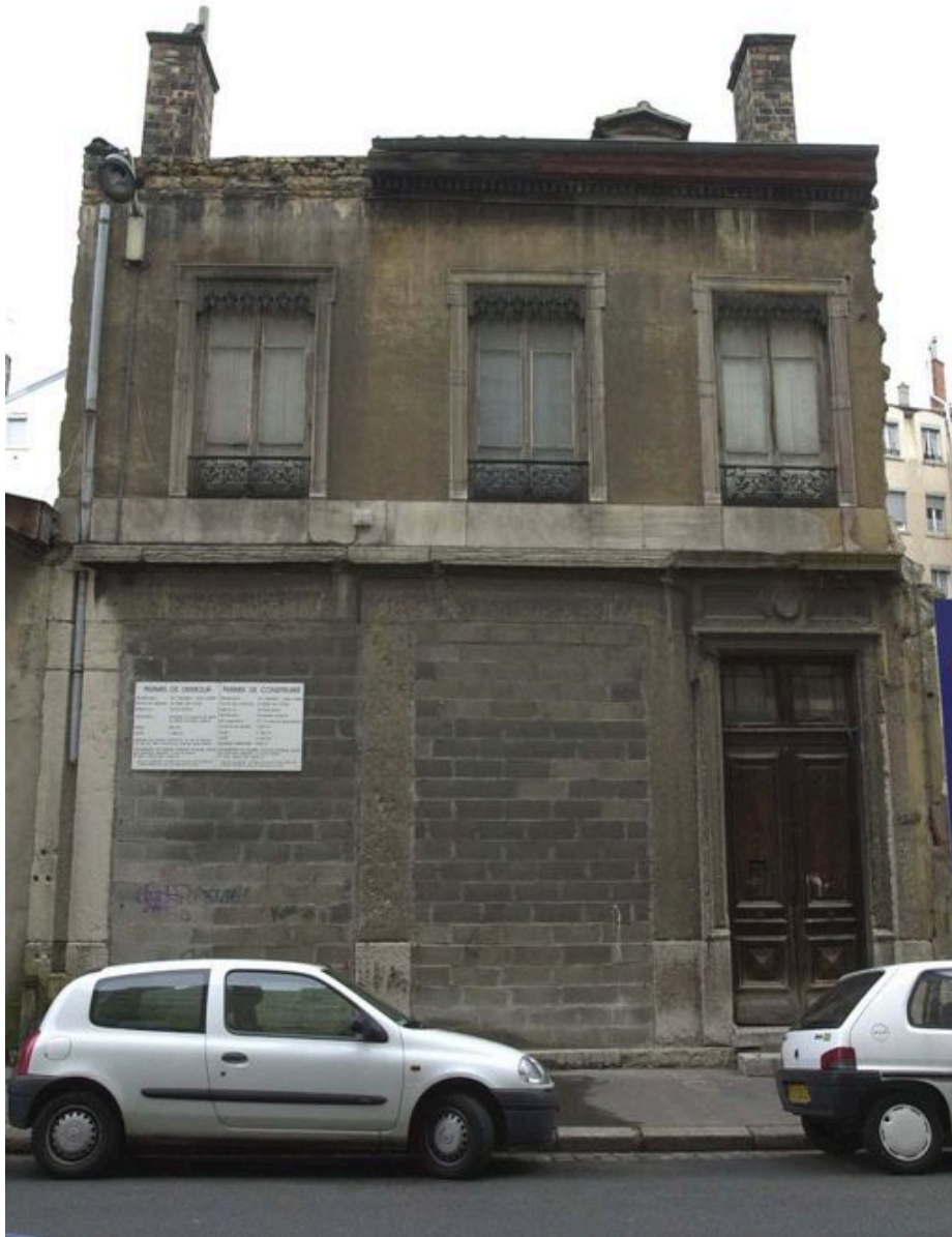
Vue de la façade de la maison démolie en 2001
