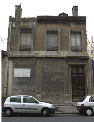
Vue de la façade de la maison démolie en 2001 Phot. François Blanchetière IVR82_20016901580NUCA
