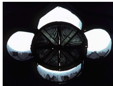
Vue de la baie H Phot. Bruno Cougnassout IVR82_19847300060ZA
