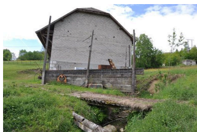
Mur pignon nord du moulin Phot. Samir Mahfoudi, Autr. Samir Mahfoudi IVR82_20107403059NUCA
