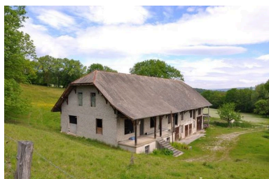
Elévation sud-est du bâtiment du moulin Phot. Samir Mahfoudi, Autr. Samir Mahfoudi IVR82_20107403053NUCA
