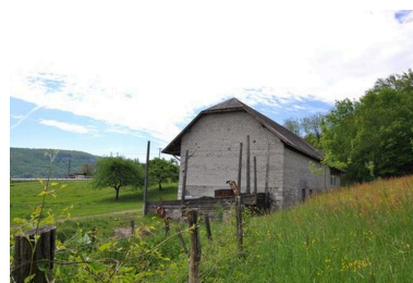
Mur pignon nord du moulin Phot. Samir Mahfoudi, Autr. Samir Mahfoudi IVR82_20107403058NUCA
