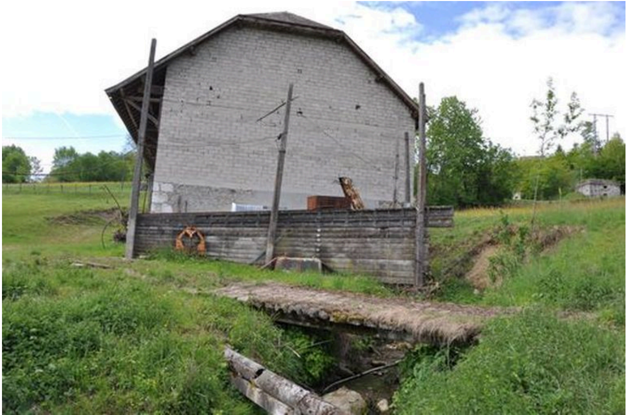
Mur pignon nord du moulin
