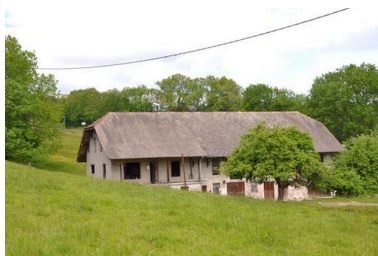
Elévation sud-est du bâtiment du moulin Phot. Samir Mahfoudi, Autr. Samir Mahfoudi IVR82_20107403054NUCA
