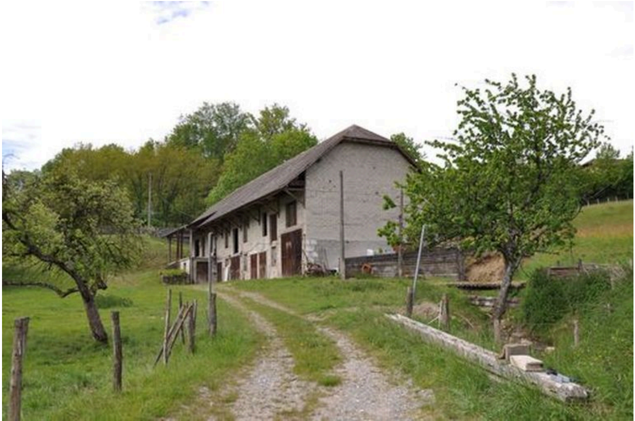
Elévation nord-est du bâtiment du moulin
