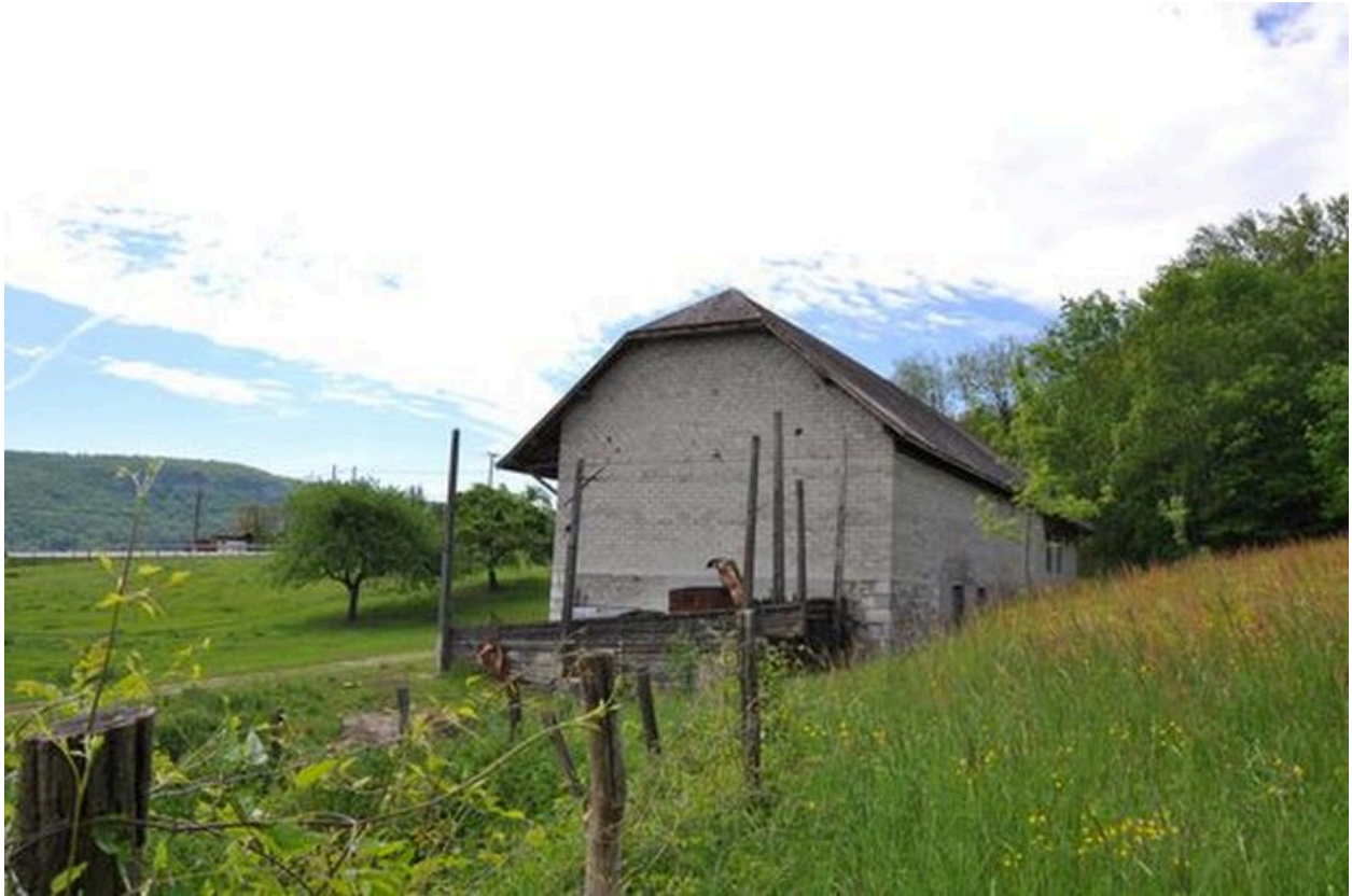
Mur pignon nord du moulin
