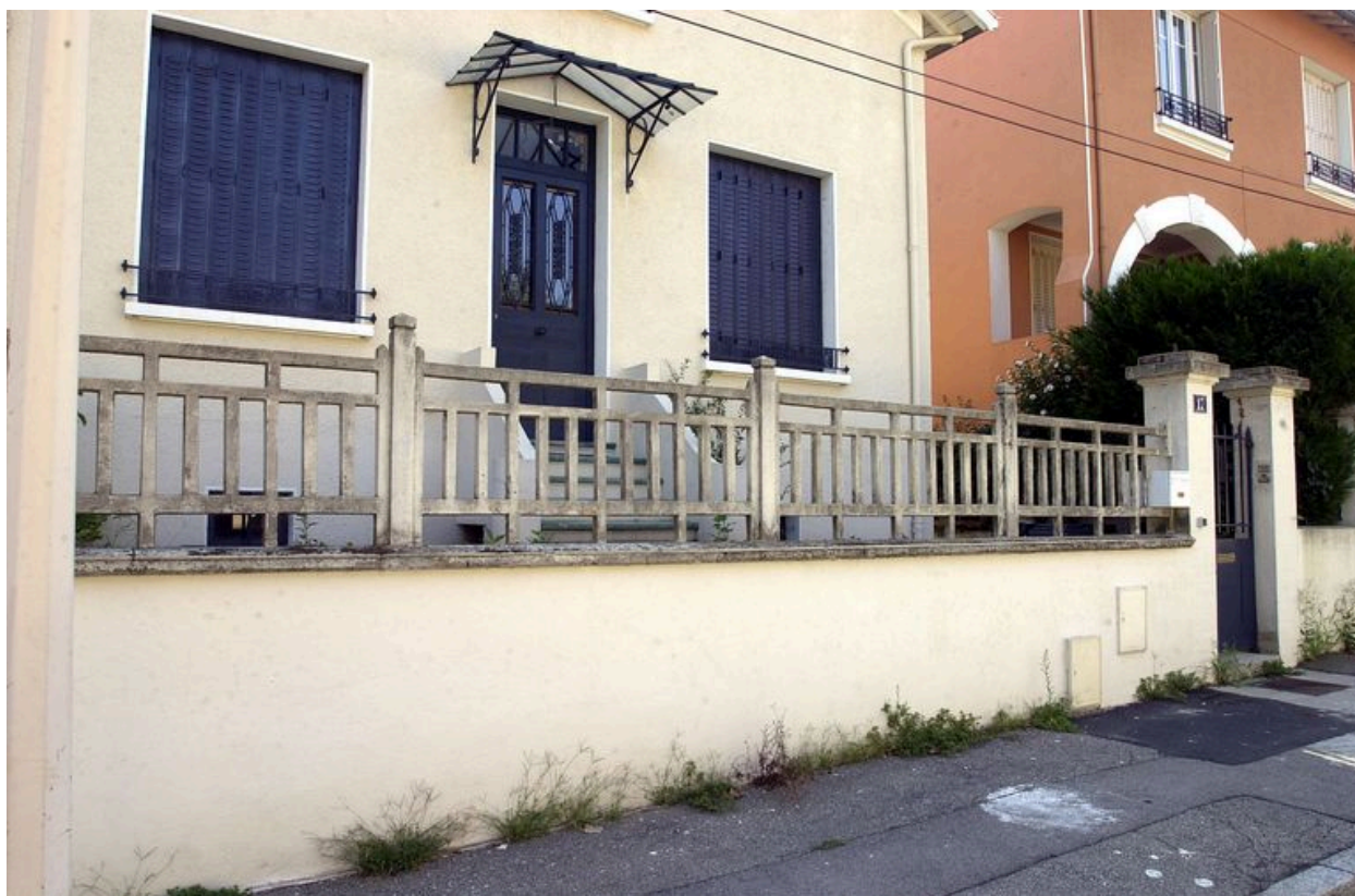
Vue de la clôture
