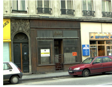
Détail de l'entrée et d'une devanture de boutique inoccupée (vêtements) Phot. Maryannick Chalabi IVR82_20006900383NUCA
