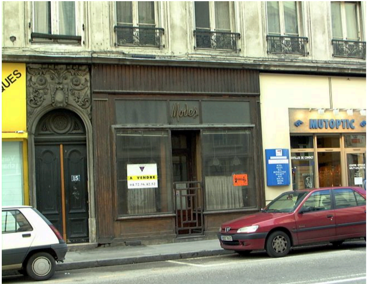
Détail de l'entrée et d'une devanture de boutique inoccupée (vêtements)
