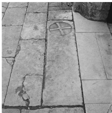
Dalle (emploi ?) devant la porte occidentale. Phot. Jean-Marie Refflé IVR82_19870100455X
