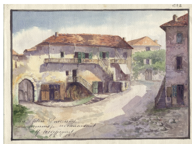
La porte de Mouxy et le début de la rue d'Enfer en 1856 Repro. François Fouger IVR82_20117300905NUCB
