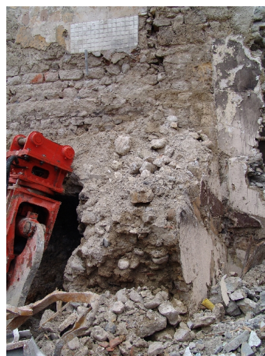
traces au pied de la maison-forte du Mollard Phot. François Fouger IVR82_20057300841NUCA
