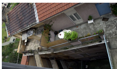
Vue d'ensemble, depuis le haut (immeuble sur la gauche de l'image) Phot. Maryannick Chalabi IVR82_20096901372NUCA
