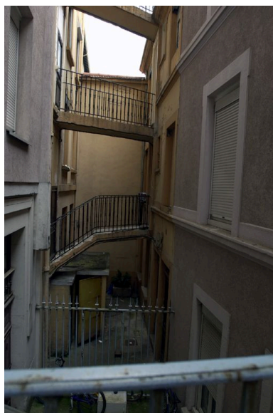
Passerelles desservant les étages Phot. Maryannick Chalabi IVR82_20096901382NUCA
