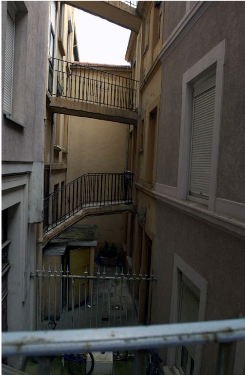
Passerelles desservant les étages
