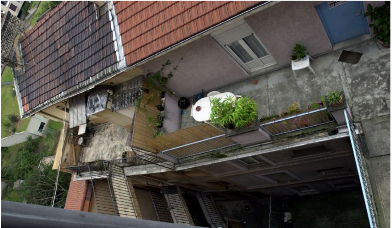
Vue d'ensemble, depuis le haut (immeuble sur la gauche de l'image)
