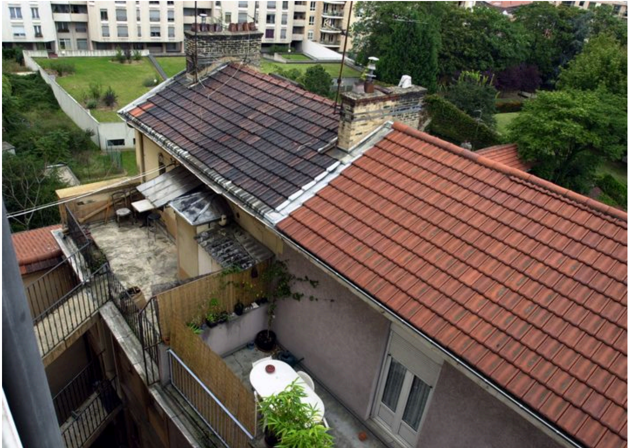
Vue partielle : dernier niveau, terrasse (immeuble à gauche de l'image)
