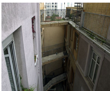
Vue partielle : premiers niveaux d'élévation Phot. Maryannick Chalabi IVR82_20096901388NUCA
