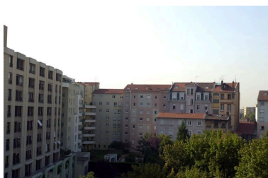
Elévation postérieure, depuis le nord Phot. Maryannick Chalabi IVR82_20096901395NUCA
