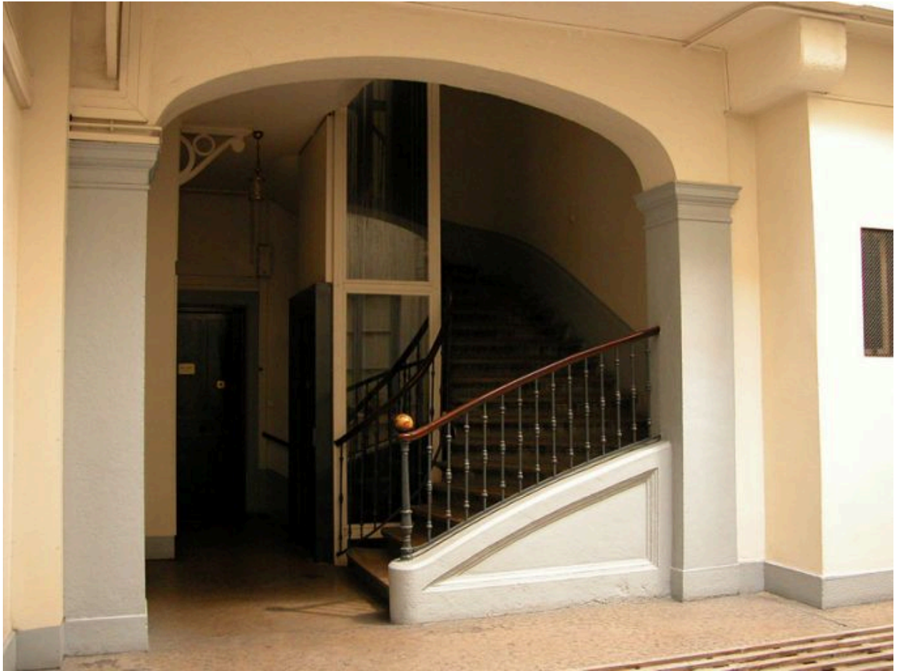
Escalier, palier du 1er étage vu depuis la cour
