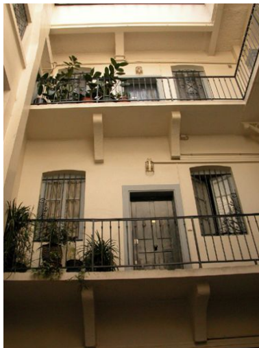
Cour, revers du corps sur rue, détail des 2e et 3e étages Phot. Phot. Inv. V. Belle IVR82_20046900613NUCA
