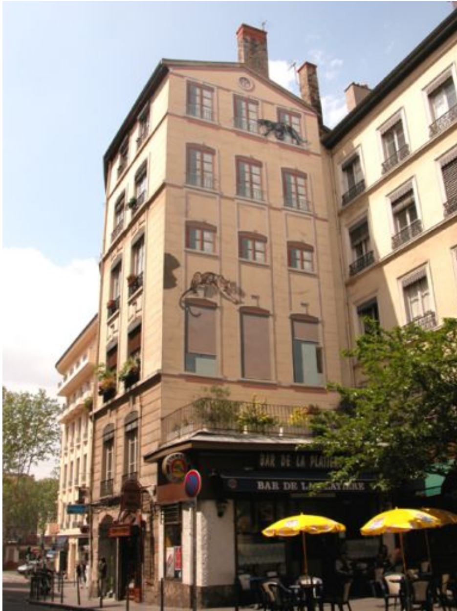
Pignon peint vu depuis la rue de la Platière
