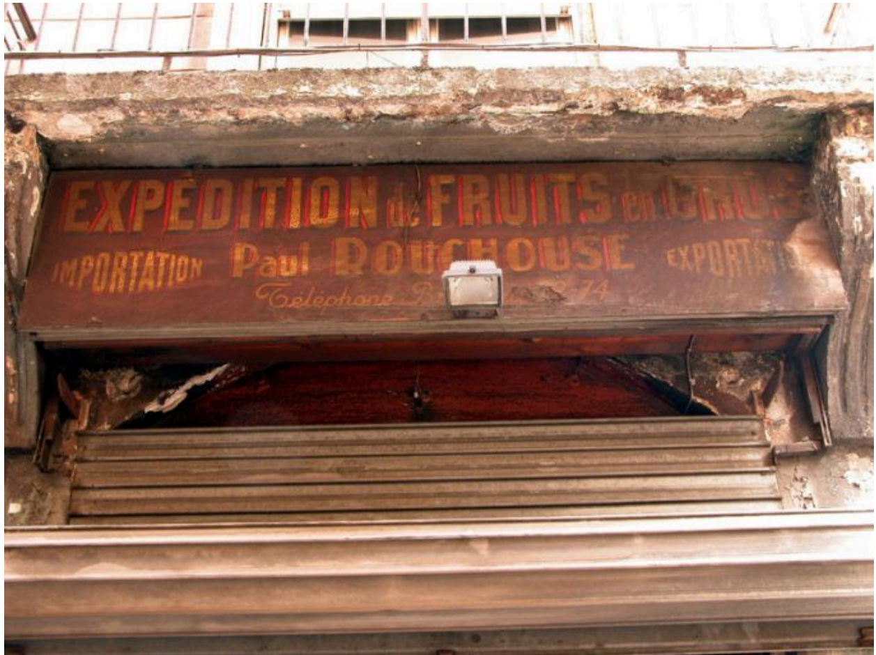
Façade sur l'impasse de la Platière, enseigne
