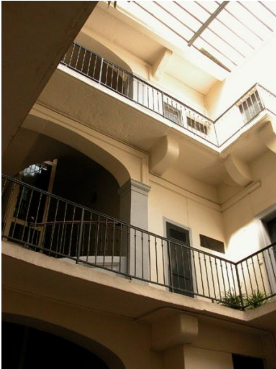
Cour, ouvertures de l'escalier et coursières des étages 2 à 4
