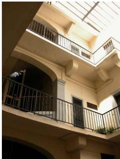
Cour, ouvertures de l'escalier et coursières des étages 2 à 4 Phot. Phot. Inv. V. Belle IVR82_20046900612NUCA
