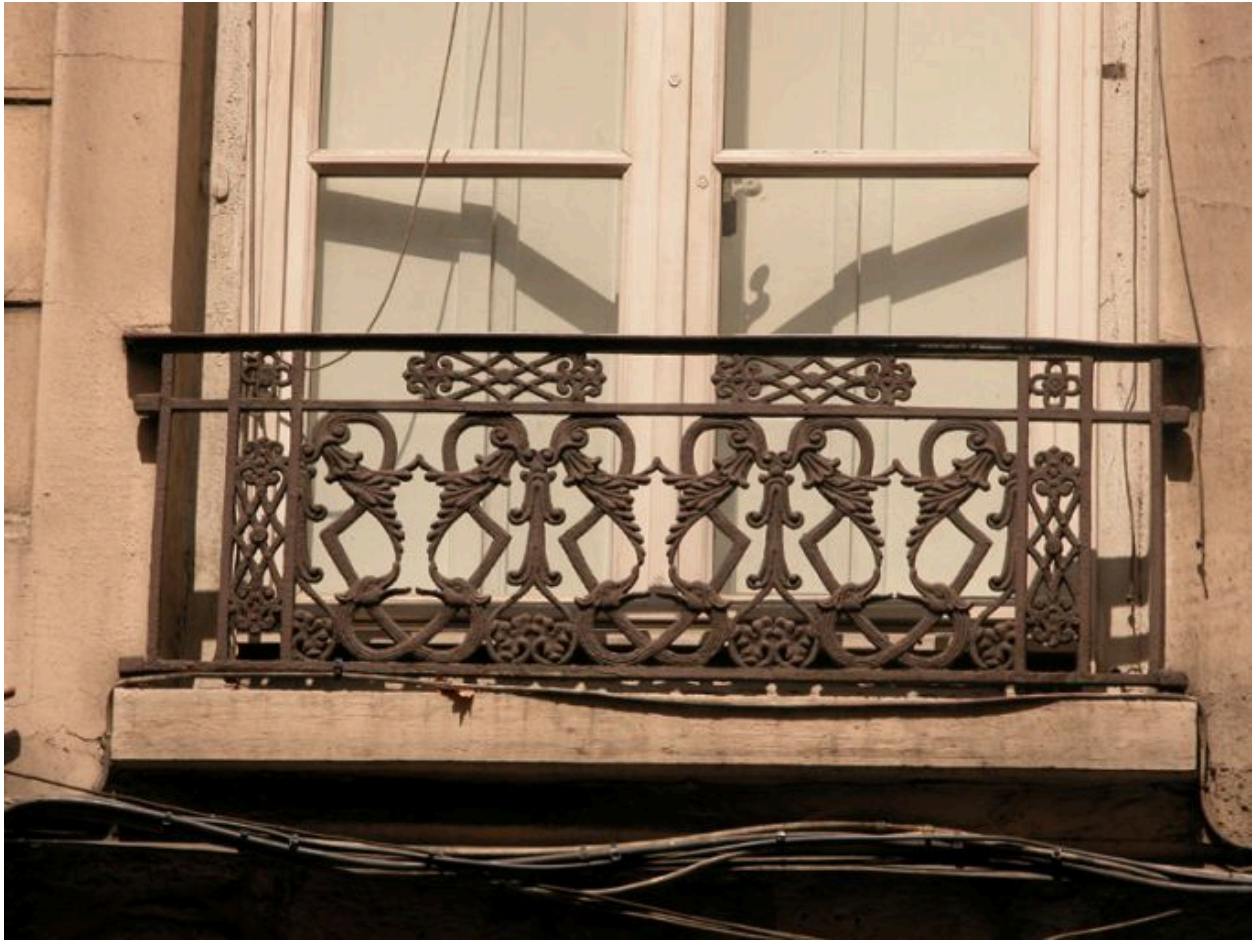
Façade sur rue, détail du garde-corps d'une fenêtre du 1er étage
