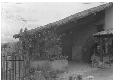
Hangar, dit poutan, contre l'étable et le fenil. Phot. Eric Dessert IVR82_19920100647P
