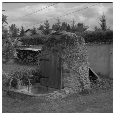
Puits couvert. Phot. Eric Dessert IVR82_19920100649X
