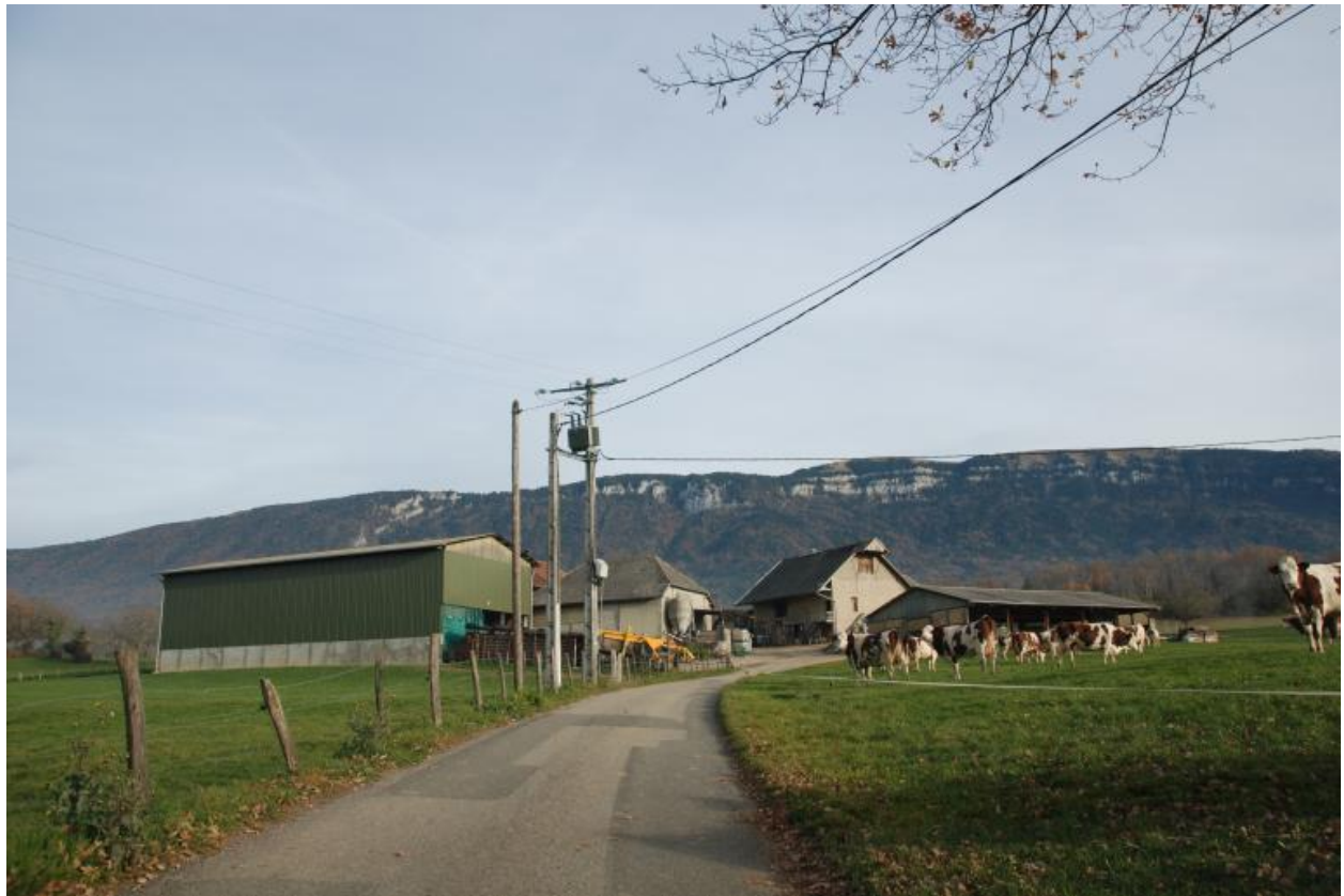
Vue générale depuis le chemin d'accès.
