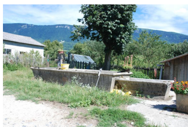
Vue du bassin. Phot. Caroline Guibaud IVR84_20207402566NUCA
