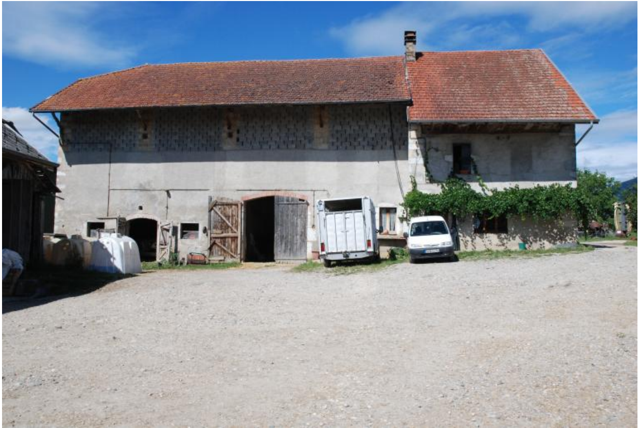
Vue d'ensemble du bâtiment principal.
