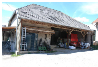
Vue de la grange-remise. Phot. Caroline Guibaud IVR84_20207402567NUCA
