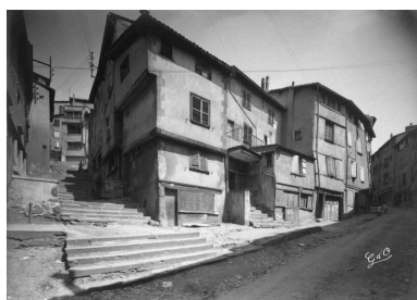
Les rues des Forgerons (à gauche) et Gambetta (à droite) à la fin du 19e ou au début du 20e siècle. IVR83_20126300394NUC
