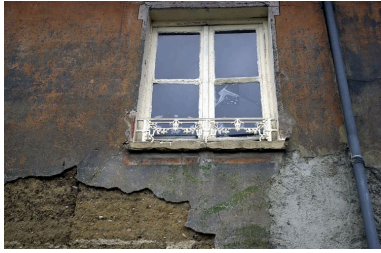
Elévation sur rue : détail d'un garde-corps Phot. Bernard Ducouret IVR82_20036903753NUCA
