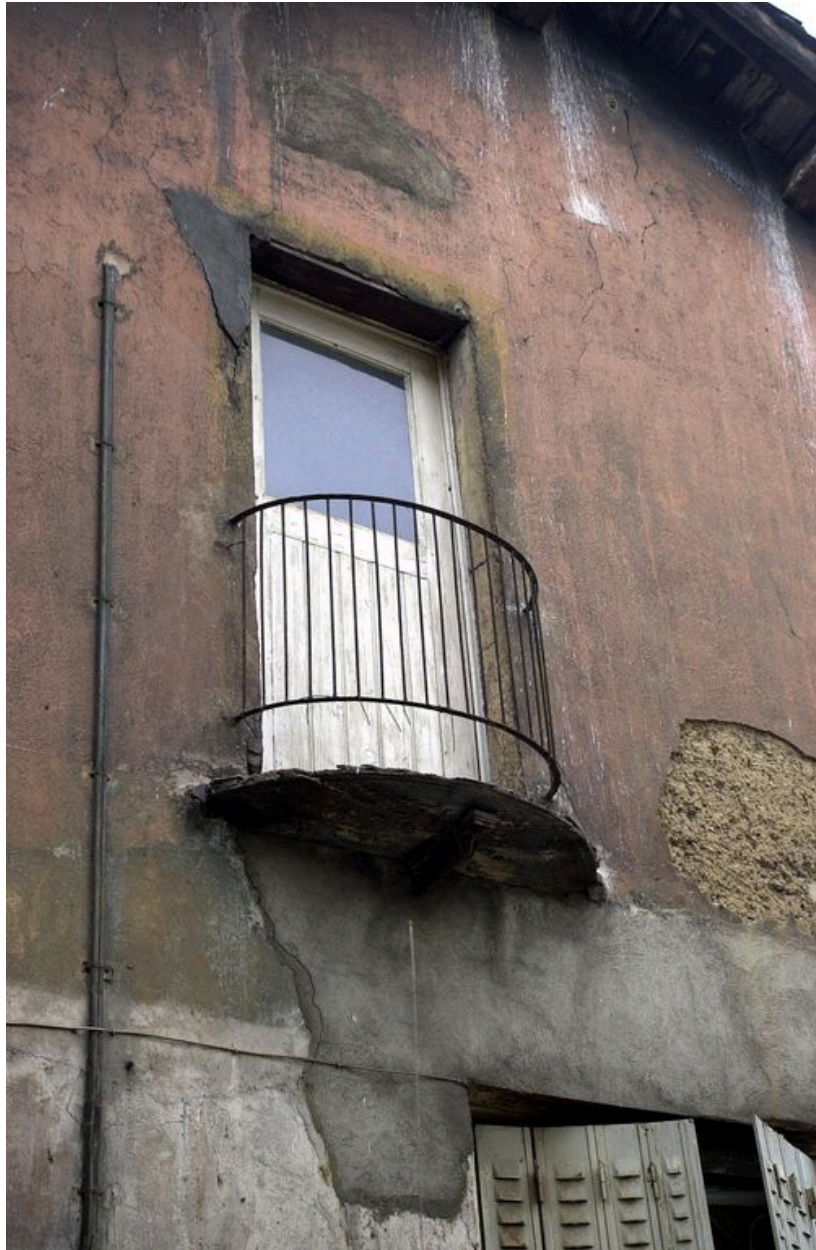
Elévation latérale : détail du balcon
