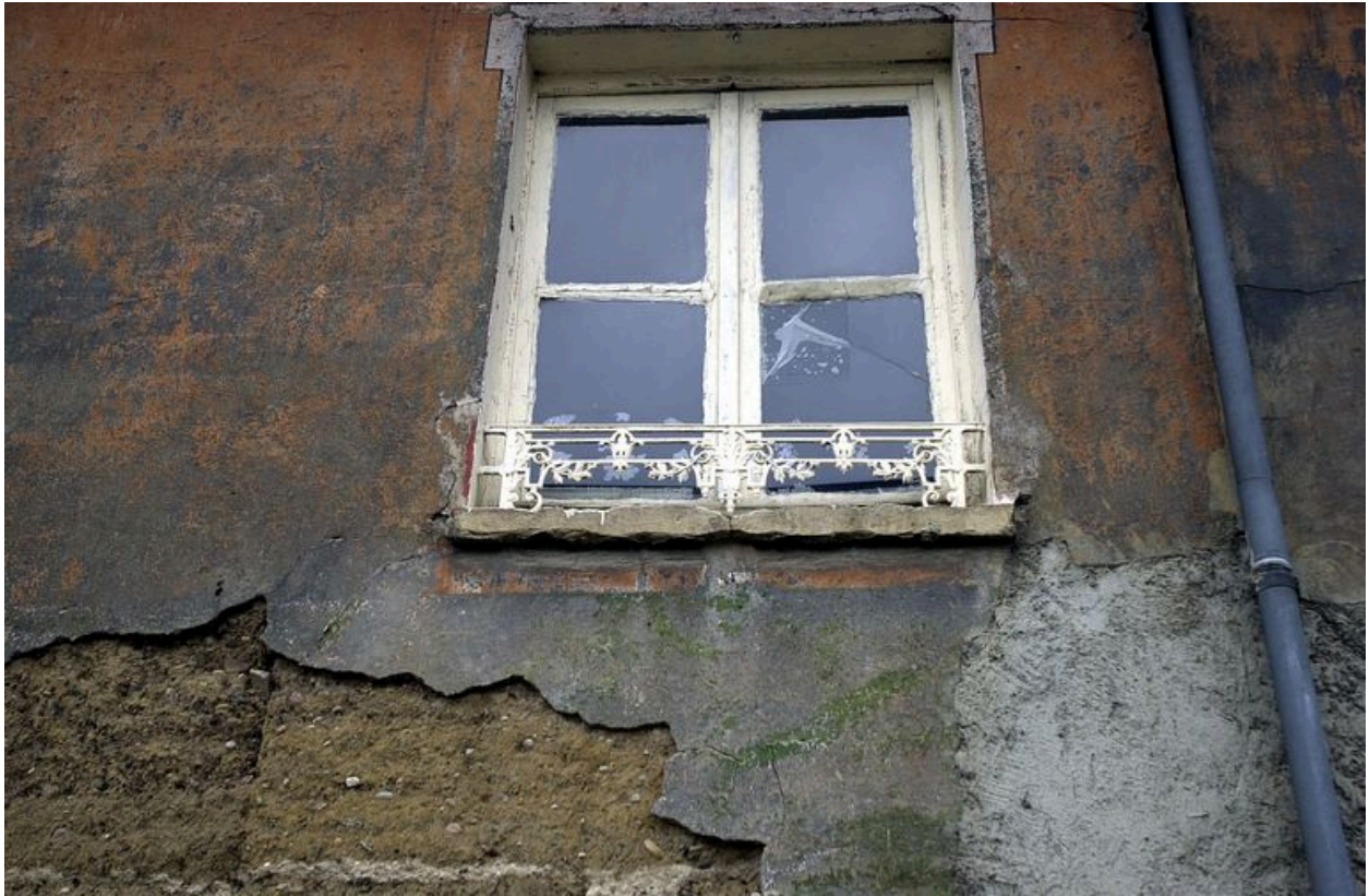
Elévation sur rue : détail d'un garde-corps
