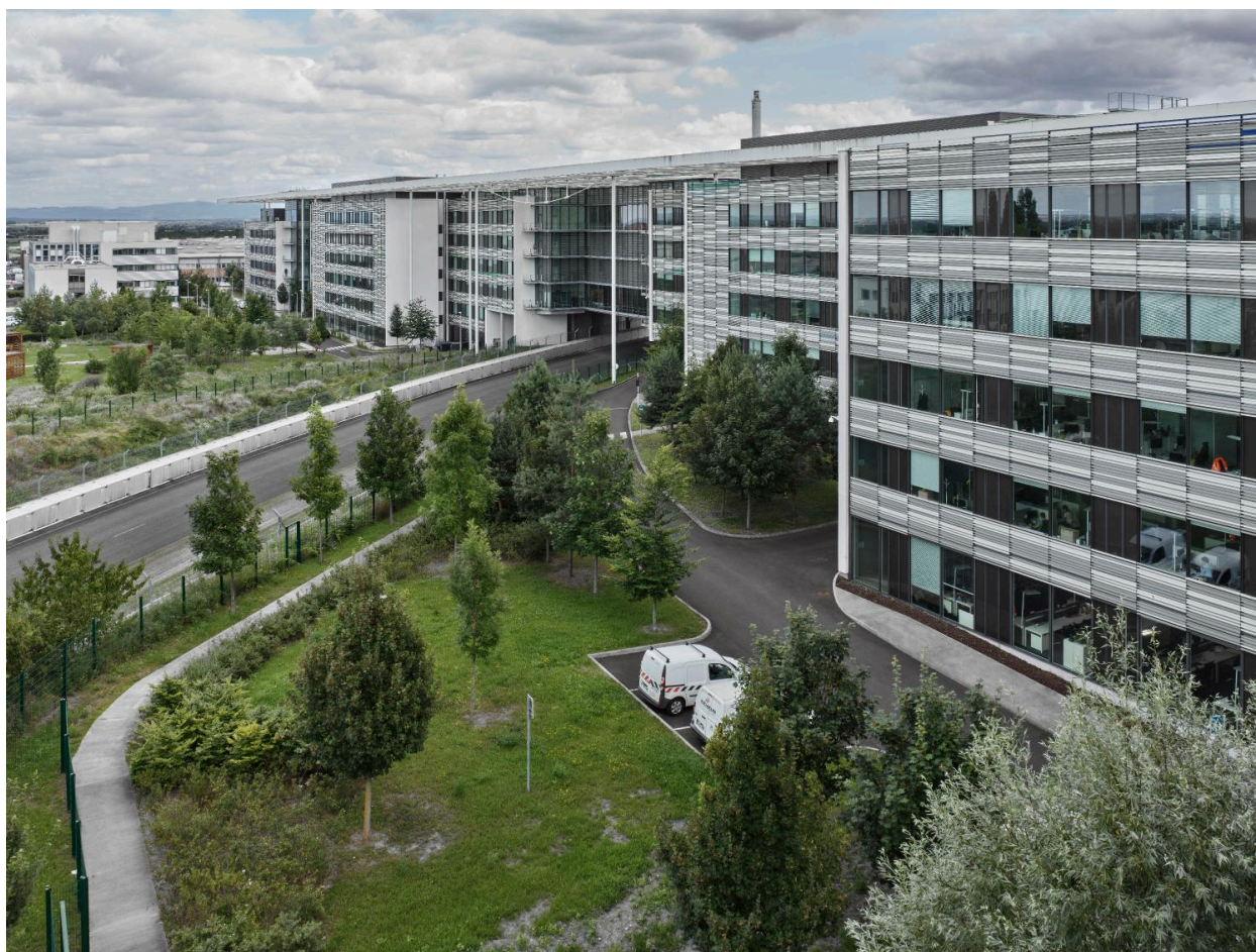
Le circuit n°1, à son passage sous le bâtiment E24 du Campus RDI, en 2024.
