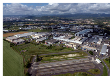
Vue aérienne des bâtiments du site en direction du sud-ouest, en 2024. Phot. Michel Pérès IVR84_20246301811NUCA
