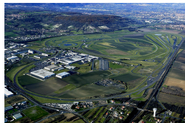
Vue aérienne du site en novembre 2002. Phot. auteur inconnu IVR84_20256301054NUCA
