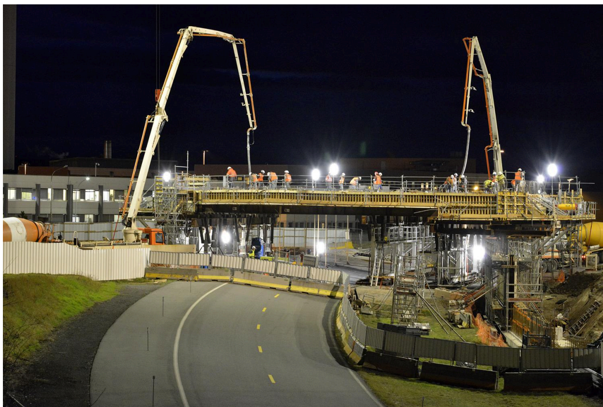
Chantier du Campus RDI en février 2014 : mise en œuvre de la dalle au-dessus du circuit n°1.
