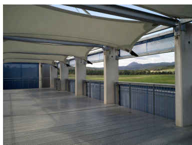
Bâtiment du Belvédère dominant les circuits d'essais, en 2024 : la terrasse du premier étage. Phot. Christian Parisey IVR84_20246301971NUC4A
