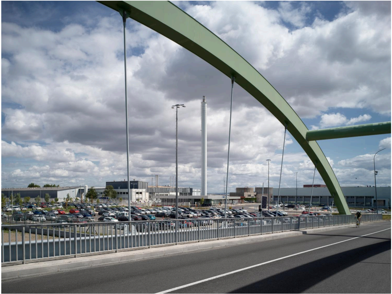
Le pont d'accès au site par la porte de Troyes, enjambant le circuit n° 1, en 2024.
