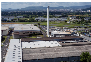
Vue aérienne, en 2024, des bâtiments F31 et B120 de la chaufferie et de la cheminée, ainsi que de F39 et E4. Phot. Michel Pérès IVR84_20246301813NUCA
