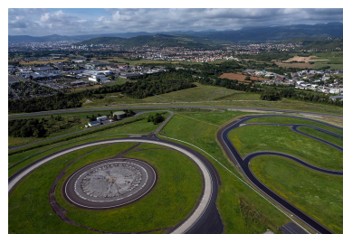
Vue aérienne partielle des circuits d'essais, en direction du nord-ouest, en 2024. Phot. Michel Pérès IVR84_20246301810NUCA
