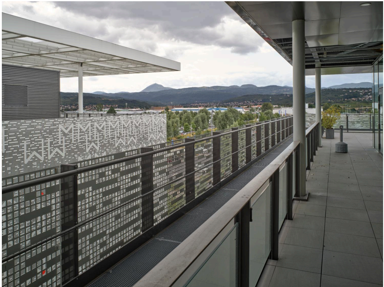
Vue sur le grand paysage, en 2024, depuis les terrasses du bâtiment E24.
