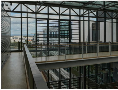
Passerelles et baies vitrées du Campus RDI, en 2024. Phot. Christian Parisey IVR84_20246301979NUC4A
