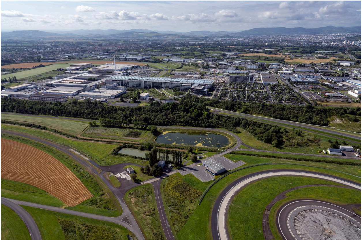
Vue aérienne, en direction du sud, des bâtiments du site depuis les circuits d'essais, en 2024.
