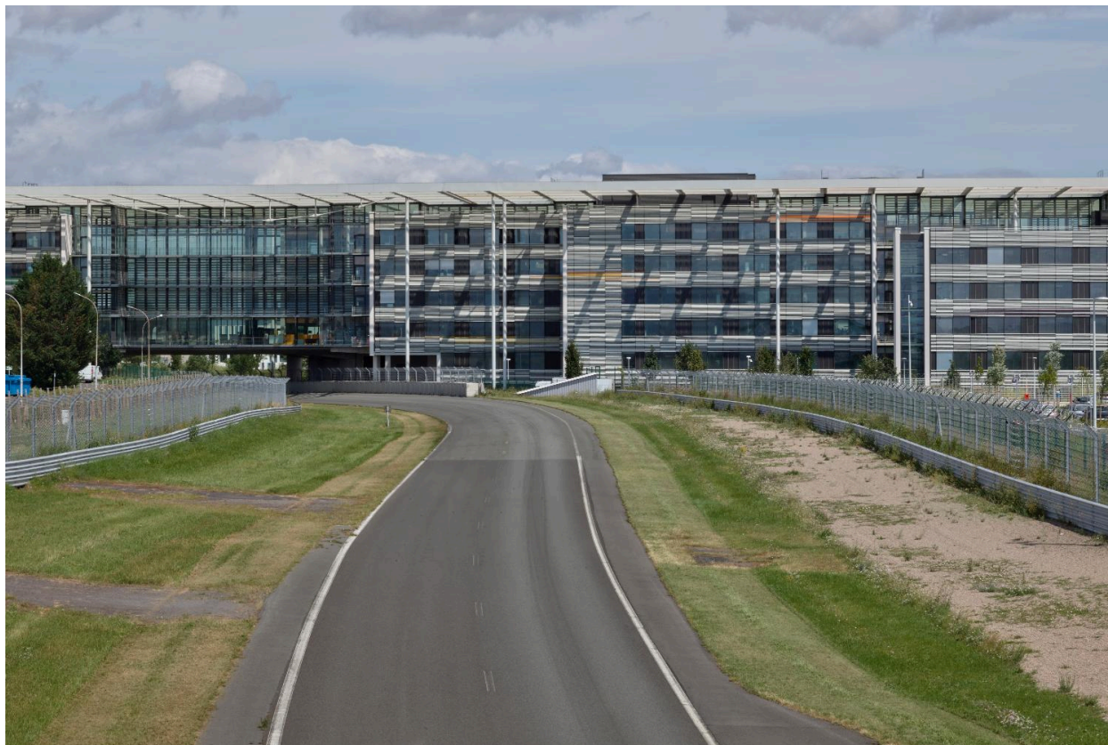
Le circuit n°1 à son passage sous le Campus RDI, côté sud, en 2024.
