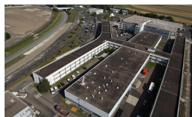
Vue aérienne, en juillet 2012, des bâtiments F34, F35 et F35 bis, et F19 au second plan. Phot. auteur inconnu IVR84_20256301057NUCA
