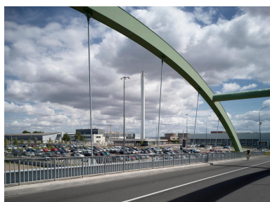
Le pont d'accès au site par la porte de Troyes, enjambant le circuit n° 1, en 2024. Phot. Christian Parisey IVR84_20246301988NUC4A
