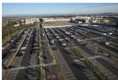
Emplacement du futur chantier du campus RDI, en octobre 2012. Phot. auteur inconnu IVR84_20256301064NUCA
