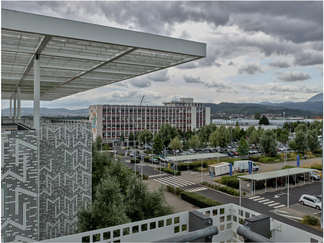
Vue sur le bâtiment G16 depuis les terrasses de E24, en 2024.
