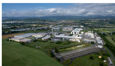
Vue aérienne du site depuis l'est, en 2024. Phot. Michel Pérès IVR84_20246301805NUCA
