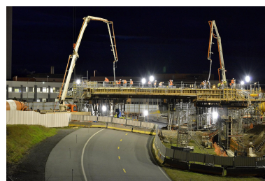
Chantier du Campus RDI en février 2014 : mise en œuvre de la dalle au-dessus du circuit n° 1. Phot. P. Chambon IVR84_20256301069NUCA
