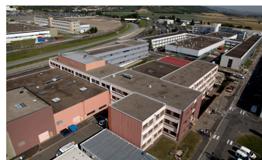
Vue aérienne des bâtiments F32 depuis le sud-est, en juillet 2012. Au second plan, les bâtiments F34, F35 et F35 bis. IVR84_20256301060NUCA
