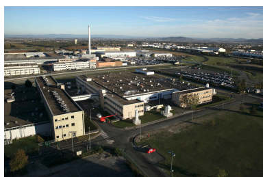
Au premier plan, les bâtiments G22 et G25 reliés par une passerelle, vus depuis le nord-ouest, en octobre 2012. Phot. auteur inconnu IVR84_20256301067NUCA
