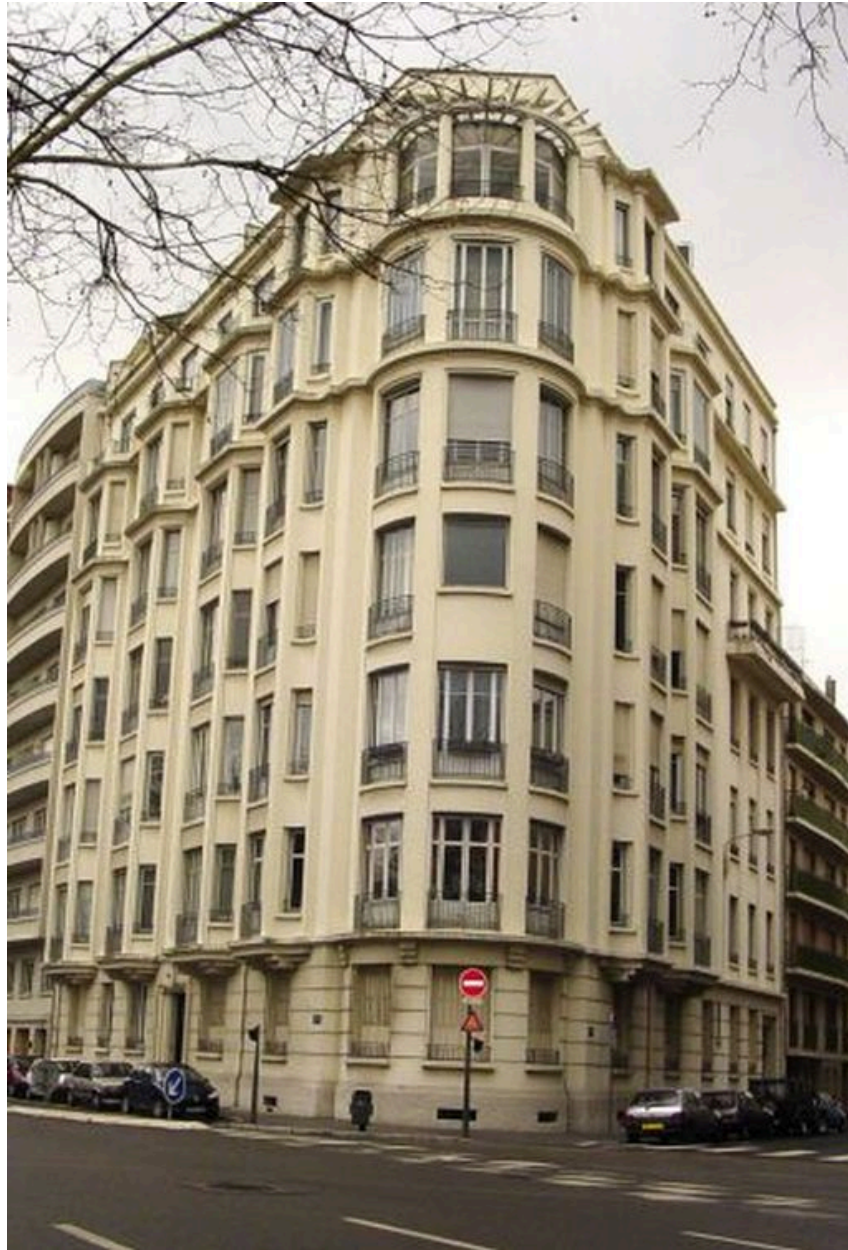
Vue générale de l'élévation depuis le nord-ouest
