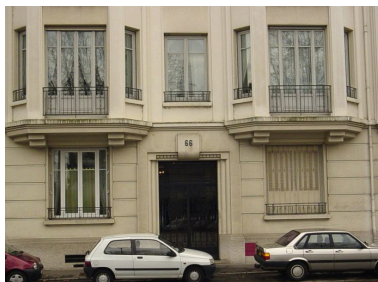
Porte d'entrée et détails des bow-windows Phot. Anaïs Beccaria IVR82_20046903322NUCA
