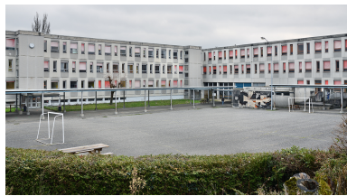
L'œuvre dans son environnement, dans la cour intérieure du lycée général et technologique Phot. Thierry Leroy IVR84_20230100034NUCAQ
