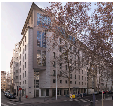
Vue générale Phot. Didier Gourbin IVR82_20126902014NUCA
