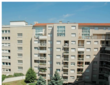
Elévation postérieure Phot. Maryannick Chalabi IVR82_20066903061NUCA
