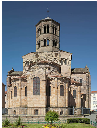
Vue du chevet Phot. Jean-Michel Périn IVR83_20136300440NUC4A
