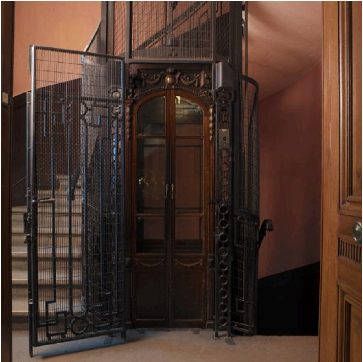
Vue de l'ascenseur, porte extérieure ouverte
