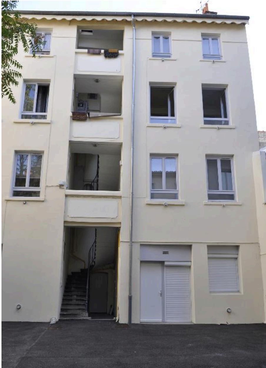
Immeuble sur cour, vue partielle de l'élévation antérieure
