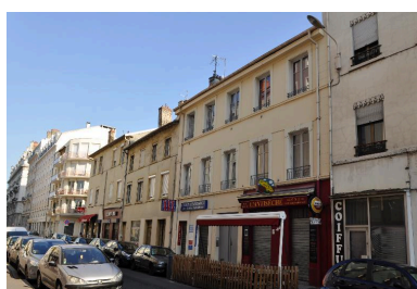
Immeuble sur rue, vue générale Phot. Catherine Guégan IVR82_20156901199NUCA
