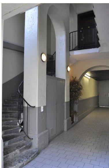
Immeuble sur rue, première volée d'escalier décalée à droite du passage cocher Phot. Catherine Guégan IVR82_20156902507NUCA
