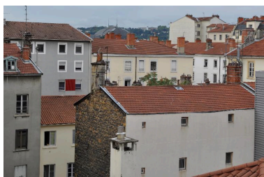
Immeuble sur cour, élévation postérieure et pignon latéral en moellons apparents Phot. Catherine Guégan IVR82_20156902514NUCA
