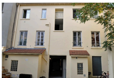
Immeuble sur rue, élévation postérieure Phot. Catherine Guégan IVR82_20156902510NUCA
