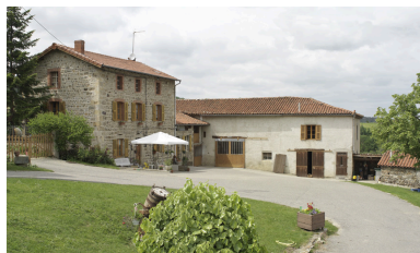
Vue générale. Phot. Eric Dessert IVR82_20064201914NUCA
