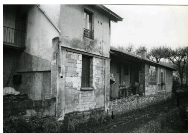
Annexes attenantes à l'arrière, longées par une dérivation du ruisseau du Tillet Repro. Denys Harreau IVR82_20147300023NUCB
