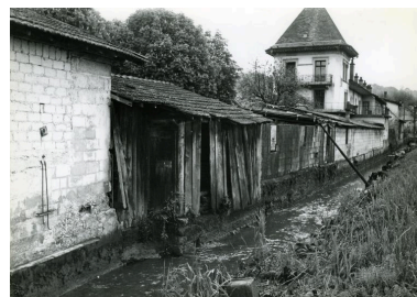
Dérivation du ruisseau du Tillet longeant la propriété Repro. Denys Harreau IVR82_20147300022NUCB
