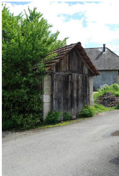
Vue d'ensemble extérieur. Phot. Thierry Monnet IVR84_20187400365NUCA
