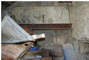
Vue intérieure du four. Phot. Thierry Monnet IVR84_20187400366NUCA
