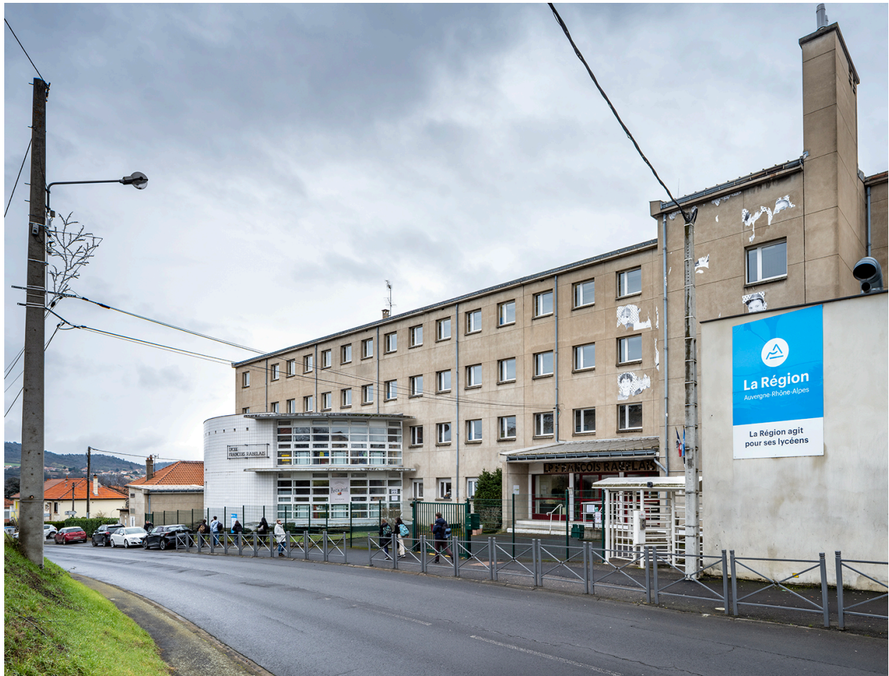
Élévation principale depuis le nord-ouest
