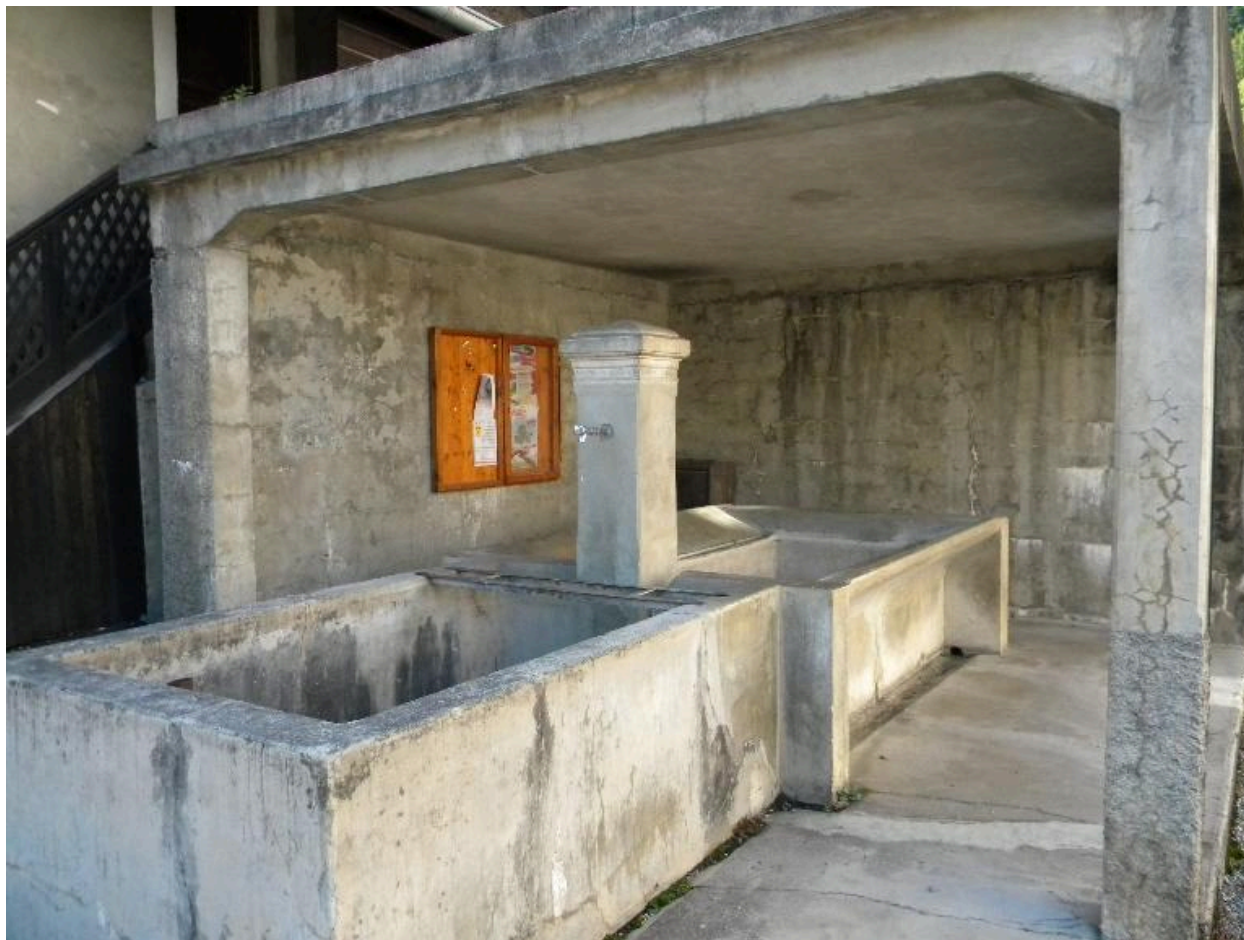
Vue d'ensemble du bassin-lavoir couvert.
