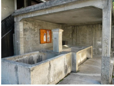
Vue d'ensemble du bassin-lavoir couvert. Phot. Jérôme Daviet IVR82_20137400955NUCA
