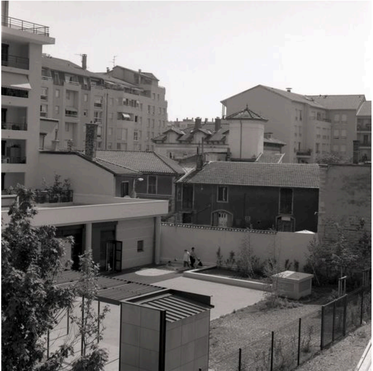
Vue d'ensemble depuis l'école Jean-Pierre-Veyet à l'ouest
