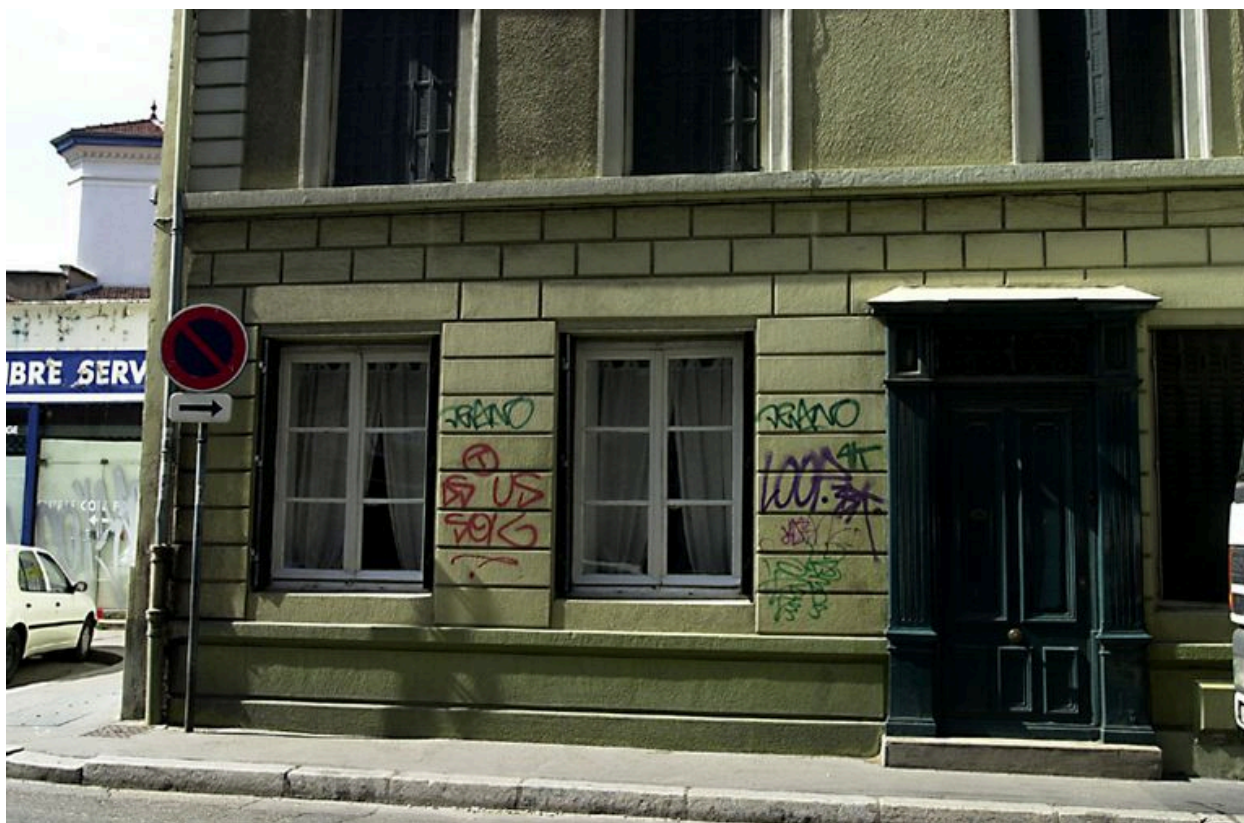
Détail du rez-de-chaussée
