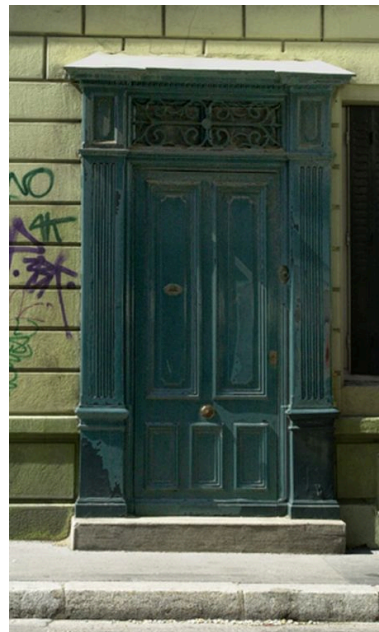
Détail de la porte d'entrée Phot. Lore Derail IVR82_20036900434NUCA
