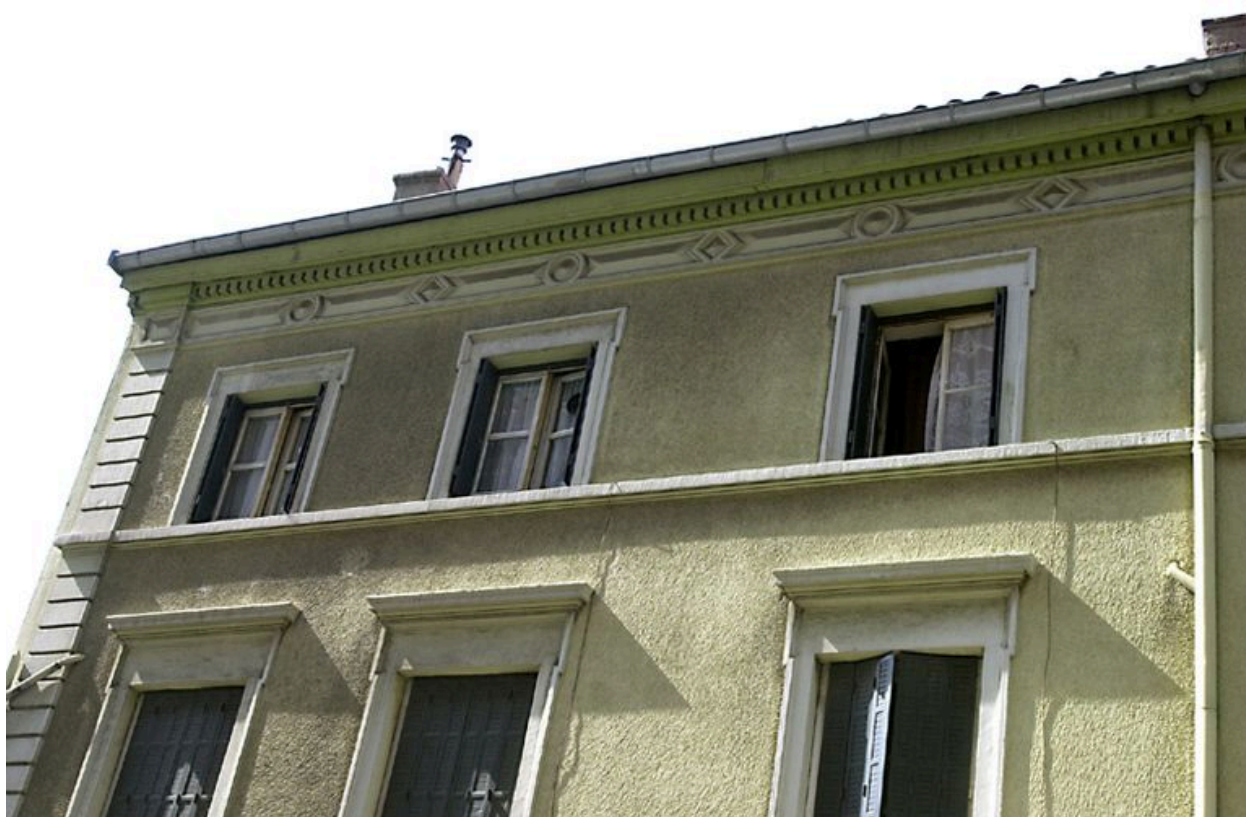
Détail de la façade sur rue
