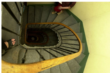
L'escalier depuis le haut Phot. Lore Derail IVR82_20036900442NUCA
