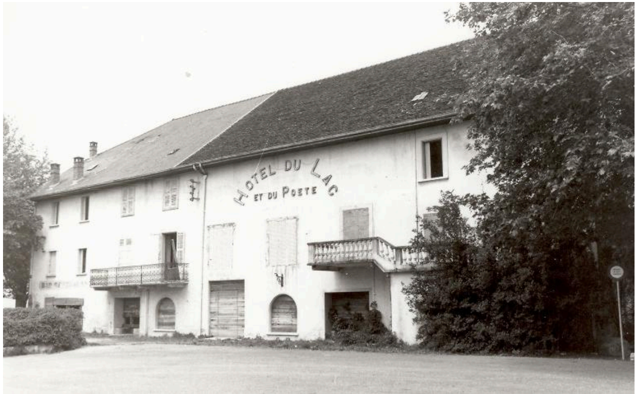
Façade sud avant démolition, 1982
