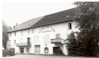
Façade sud avant démolition, 1982 Repro. Denys Harreau IVR82_20157300993NUCB
