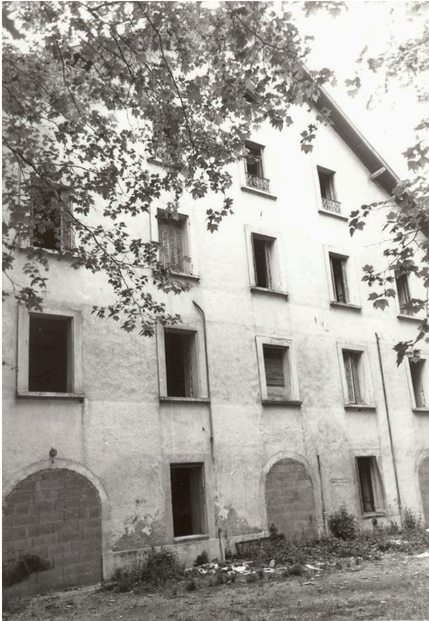
Pignon avant démolition, 1982
