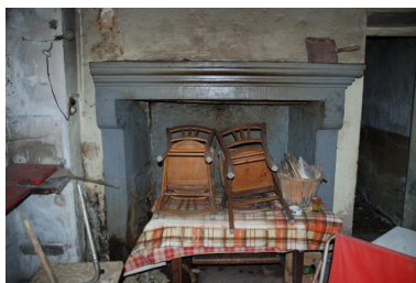
Vue intérieure : cheminée. Phot. Thierry Monnet IVR84_20187301248NUCA
