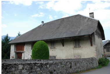
Vue arrière. Phot. Thierry Monnet IVR84_20187301260NUCA
