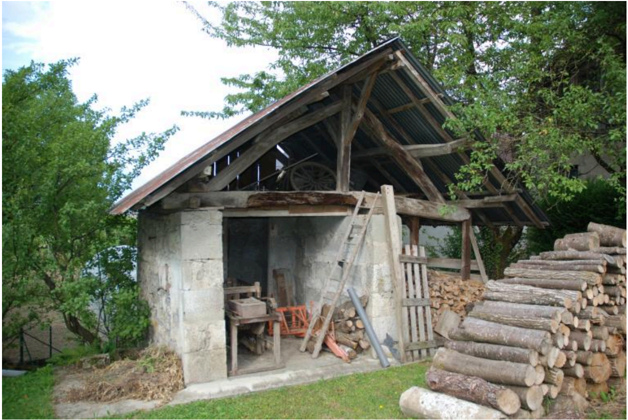
Vue du four à pain.
