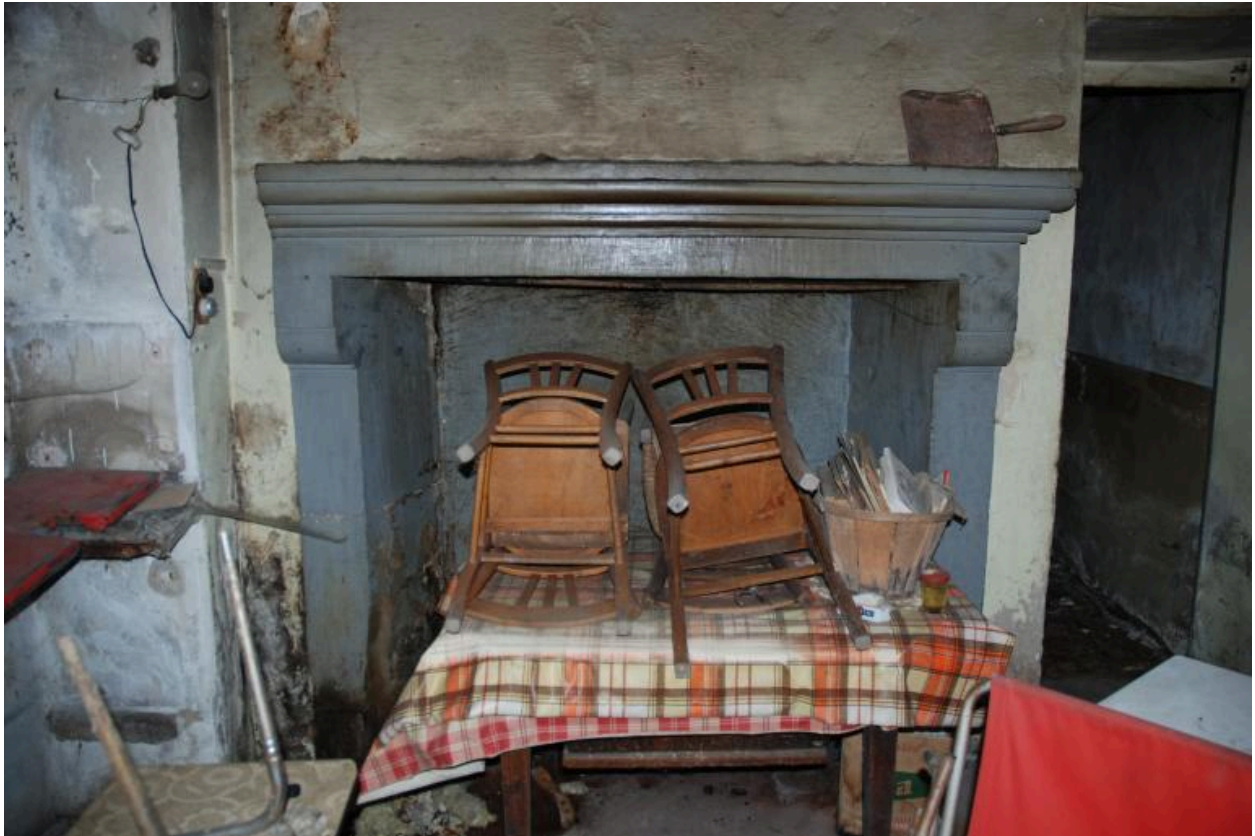
Vue intérieure : cheminée.
