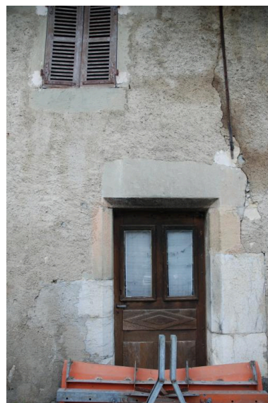
Détail de la porte d'entrée. Phot. Thierry Monnet IVR84_20187301262NUCA
